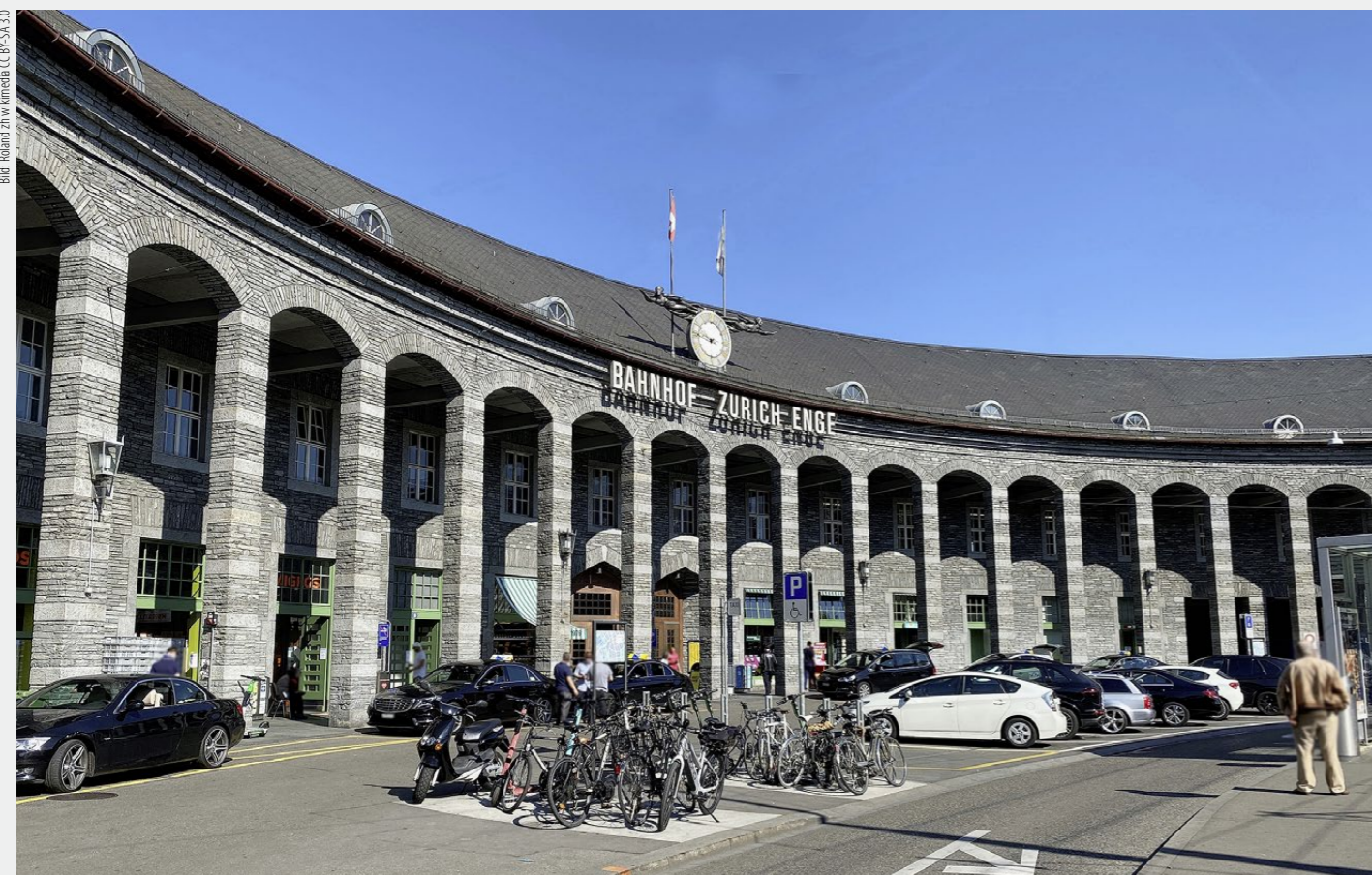
Für den um 1927 eröffneten Bahnhof Engle wählten die Brüder Pfister Tessiner Granit als Baustoff.
