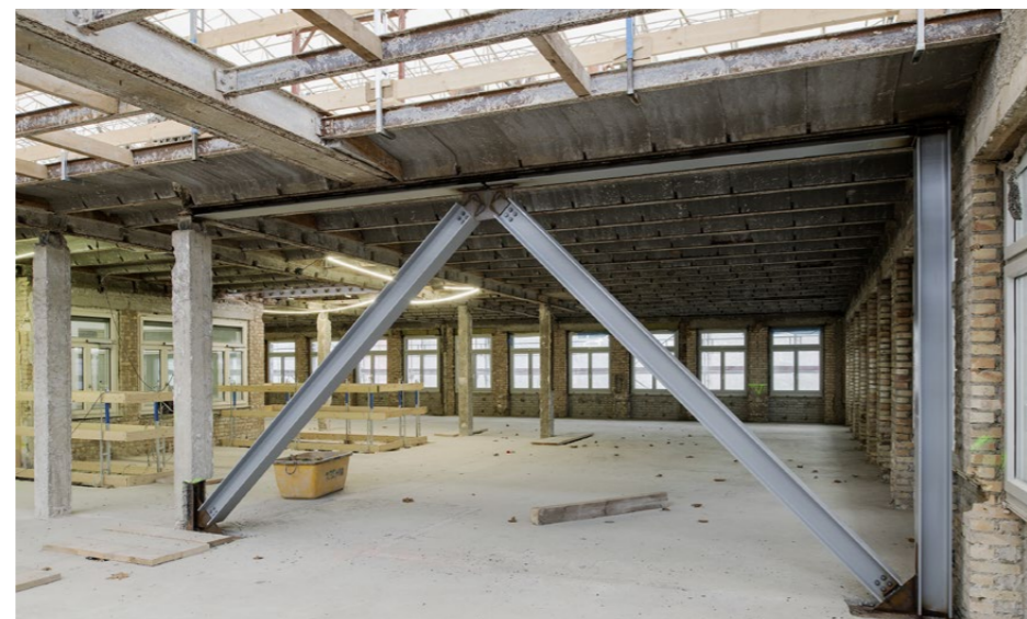
Einer der wichtigsten Eingriffe im Zuge der Sanierung ist die Erdbebenertüchtigung durch den Einbau solcher Stahlstützen.
