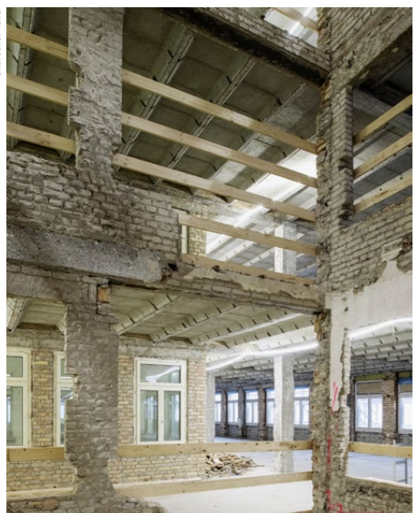
Atrium für Tageslicht: Eines der gestalterischen Elemente, die unter Schutz stehen.
