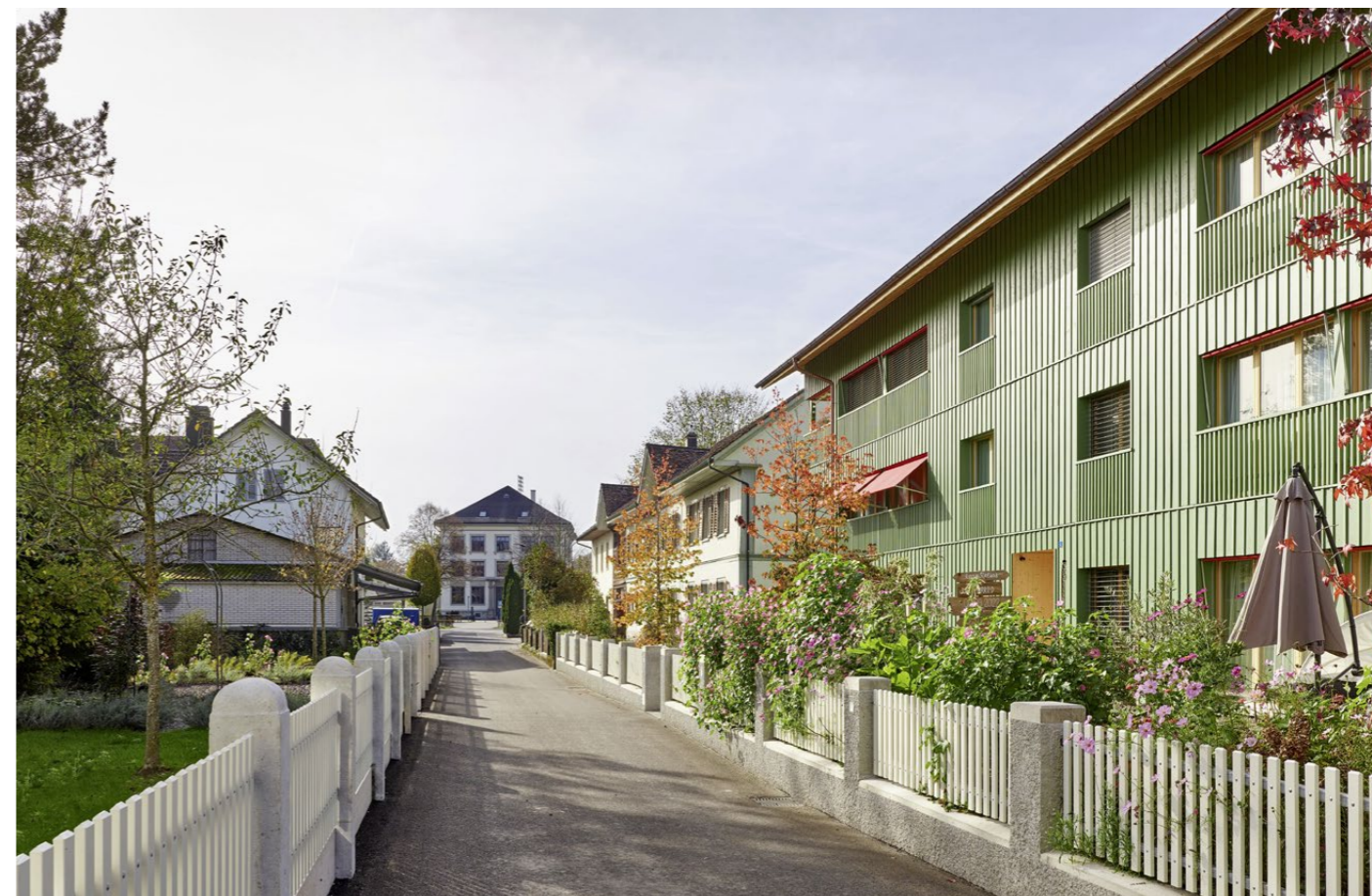
Blick in die Rotfarbgasse: Ausgehend vom Baubestand wurden die Position, das Volumen und die Dachform des Neubaus bestimmt. Dieser nimmt Bezug auf das klassizistische, lang gezogene Wohnhaus mit Versammlungslokal, ehemals ein Teil der Werksiedlung «Rotfarb».
