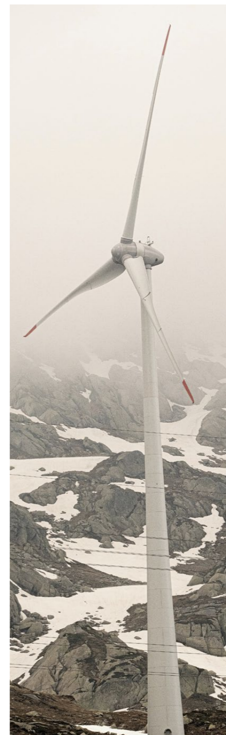
Windturbine auf dem Gotthard, oberhalb der Baumgrenze.
