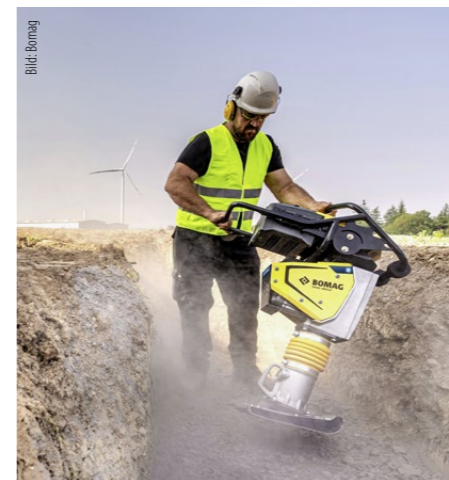
Dass die Zukunft der leichten Verdichtung elektrisch wird, zeigt auch Bomag mit seinem Akkustampfer «BT 60 e» für lärmarme, abgasfreie Verdichtung in sensibler Arbeitsumgebung.
