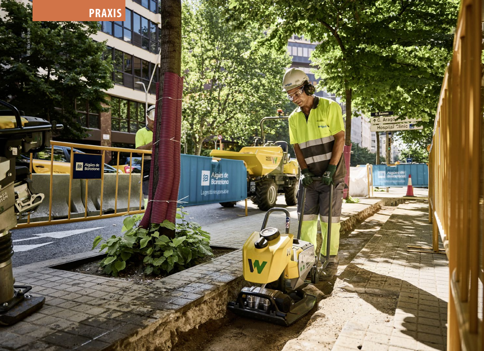
Im Stadteinsatz leichter Verdichter – hier die Rüttelplatte «APS 1340e» von Wacker Neuson – zeigen alle Pfeile in Richtung Elektroantrieb.
