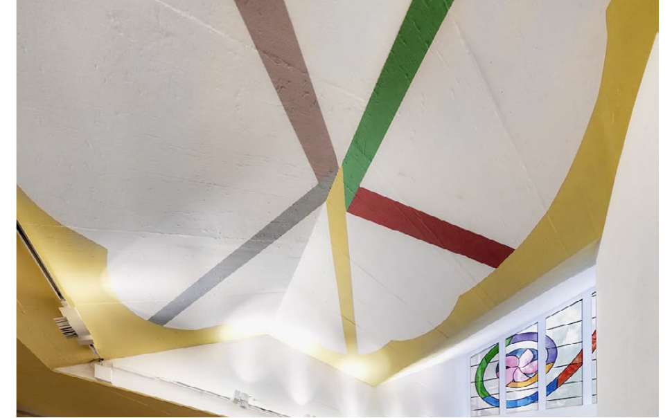
Ansicht des zentralen Deckengemäldes mit farbigem Fünfstern und des Glasgemäldes über dem Altarbereich in der Kapelle des Alters- und Pflegeheims St. Martin in Olten SO.
