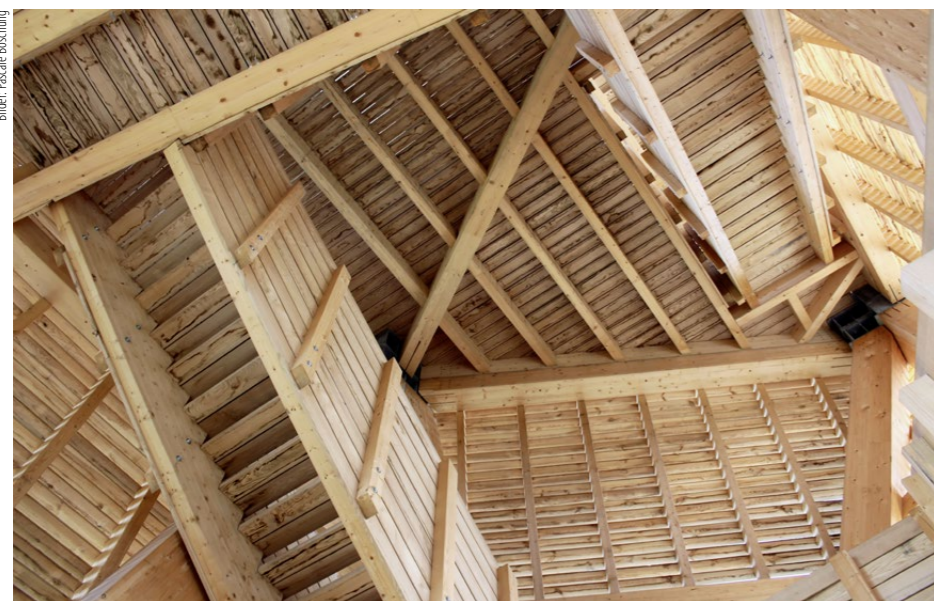
Die einzelnen Elemente des Turms sind bis auf das Haupttragwerk nicht verleimt. Die Bretter können nach Ende ihrer Lebensdauer somit einfach im Wald bleiben.
