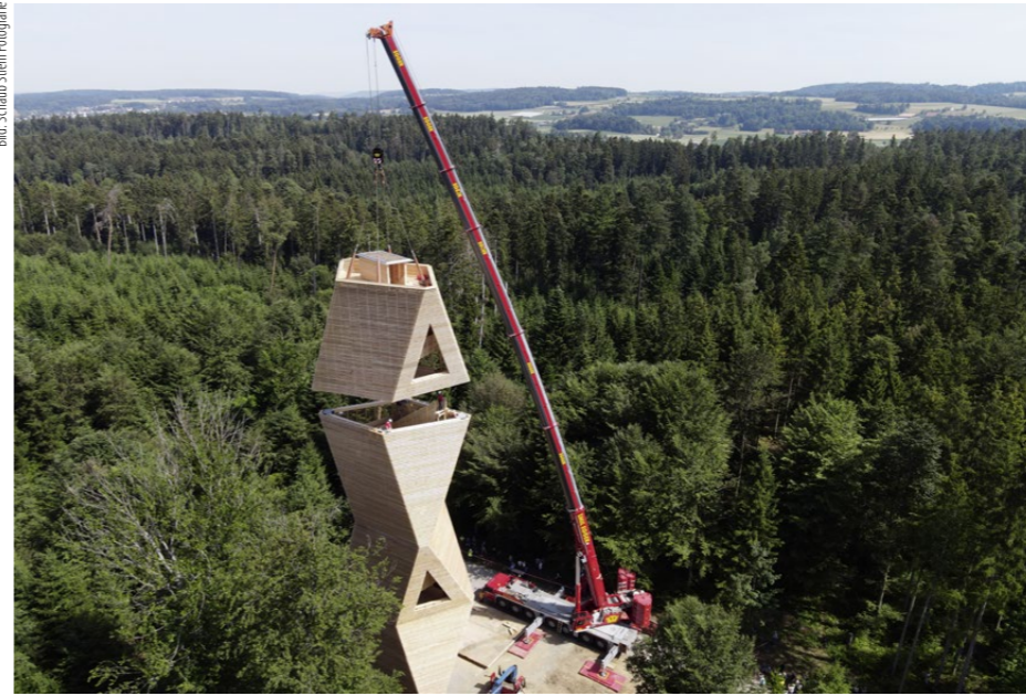
Der Bau des Turms erfolgte etappenweise in vier Segmenten von je 10 Metern Höhe, die mittels einem Teleskopkran aufeinandergestapelt wurden.
