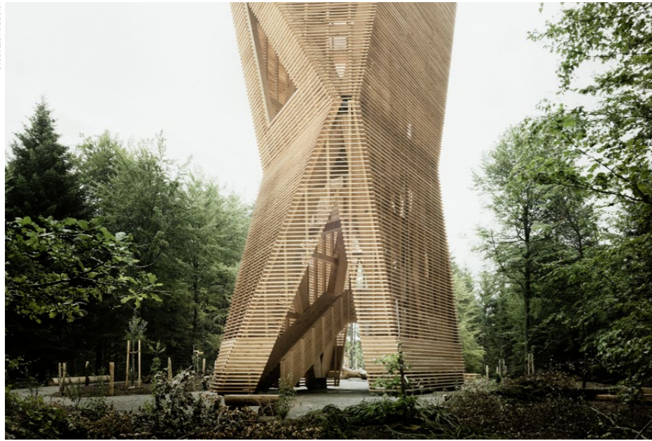
Die Bauteile wurden zum Teil vormontiert auf die Baustelle geliefert und vom Primär-Tragwerk, über Treppen, Podeste und Plattformen bis zur Aussenschalung auf dem Bauplatz komplett zusammengebaut.
