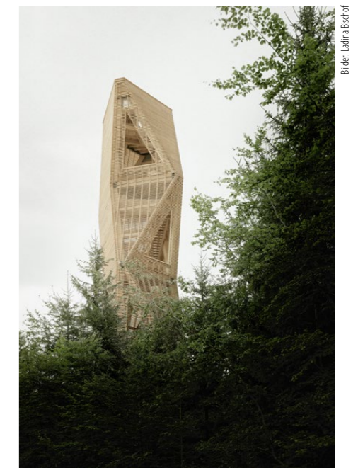
209 Stufen führen bis nach oben. Je nach Windverhältnissen schwankt das Bauwerk ganz leicht.
