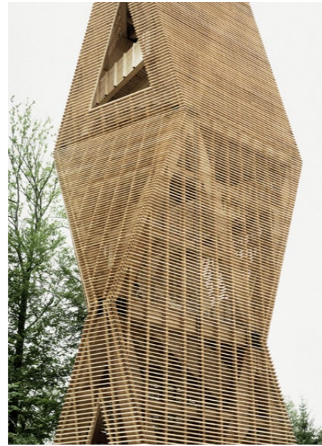
Umhüllt wird das Bauwerk von einer Zahnleistungsschalung aus Föhre.
