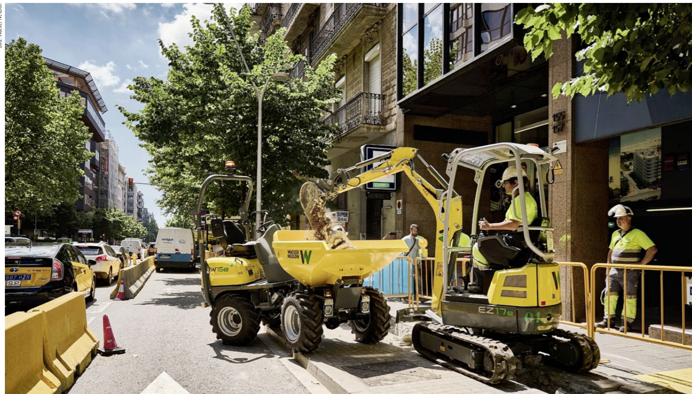
Emissionsfreier Leitungsbau in Barcelona: Bei dieser Stadtbaustelle verwendete das ausführende Unternehmen komplett elektrische Maschinen, darunter einen Bagger EZ17e und einen Dumper DW15e von Wacker Neuson.
