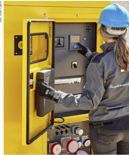
Die ZenergiZe-Serie der Energiespeichersysteme von Atlas Copco können als primäre Stromquelle dienen oder mit einem Stromerzeuger kombiniert werden.
