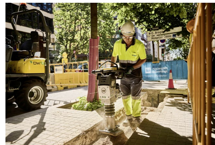
Aufbrechen, ausbaggern, verfüllen und verdichten – sämtliche Arbeitsschritte einer typischen Stadtbaustelle lassen sich mit elektrischen Maschinen von Wacker Neuson ausführen.
