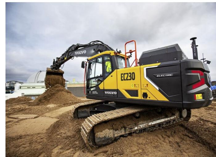
Schwedens grösste fossilfreie Baustelle liegt auf einem früheren Schlachthofareal in Stockholm. Eine Schlüsselrolle spielt ein batterieelektrischer 23-t-Bagger Volvo EC230 Electric.
