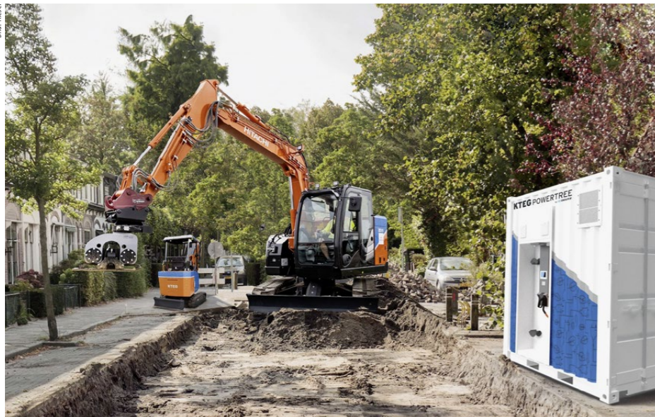
Der vom Kiesel-Tochterunternehmen KTEG gemeinsam mit Deutz entwickelte Powertree ist eine Baustellen-Ladestation im Gewand eines 10-Fuss-Seecontainers.
