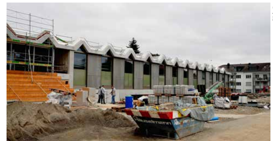
Auf der Rückseite findet das Klubhaus des Tennisclubs Unterschlupf, was durch ein anders geformtes Dach markiert wird.
