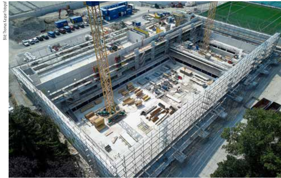
Die Halle bevor die Wände hochgezogen wurden: Im Untergeschoss musste die gesamte Technik untergebracht werden.
