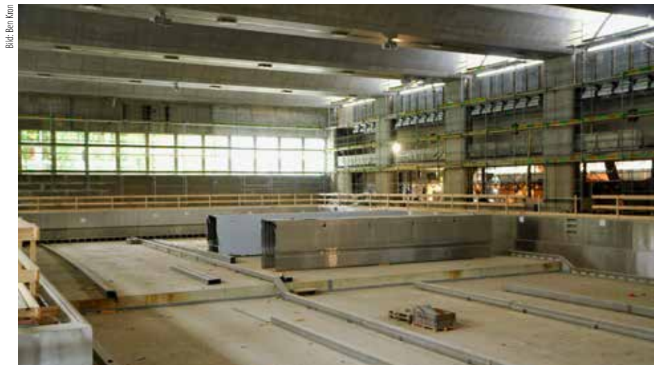
Blick ins Innere des Rohbaus: und auf die beiden Hälften der mobilen Brücke, die eine flexible Unterteilung des grossen Beckens ermöglicht.
