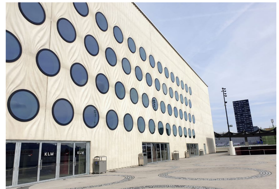
Die Arena wird von einer Sichtbeton-Fassade umgeben, die sich wie ein drapierter Vorhang um das Gebäude legt. Diese wurde vor Ort von Baumeistern aus Sichtbeton mit Weisszement gefertigt.
