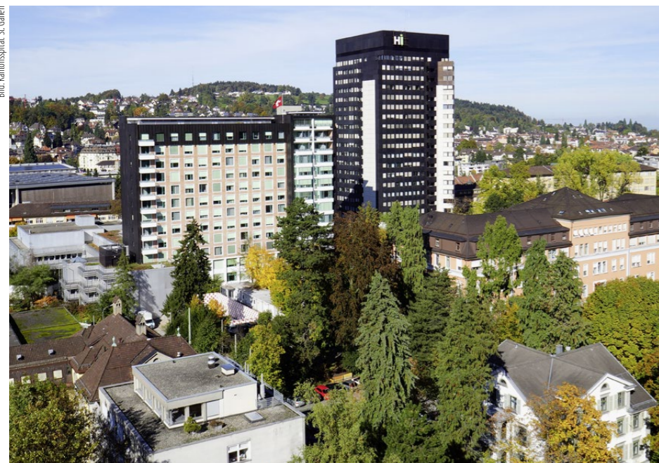
In St. Gallen streitet man sich ob der Frage, ob das Spitalhochhaus ein schützenswertes Gebäude ist.
