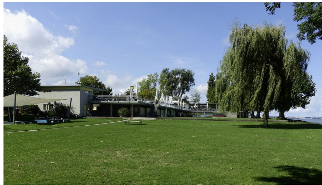
Die Liegewiese wird von einem winkelförmigen Gebäude eingefasst. Über den Garderoben erstreckt sich eine promenadenartige Terrasse, auf der sich auch ein Restaurant befindet.
