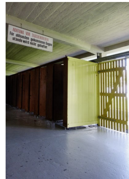
Die Garderoben unter dem Betondach sind weitgehend im Originalzustand.
