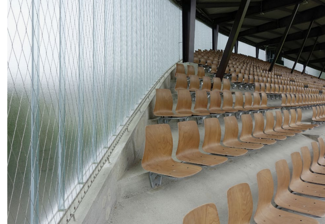
Die Profilglaswand hinter den Rängen der Tribüne wurde mit einem kleidsamen Drahtgeflecht bewilligungstauglich gemacht. Die alten Sperrholz-Schalenstühle ersetzen neue Modelle, die, leicht nach hinten abgekippt, die Fluchtwegmasse einhalten.
