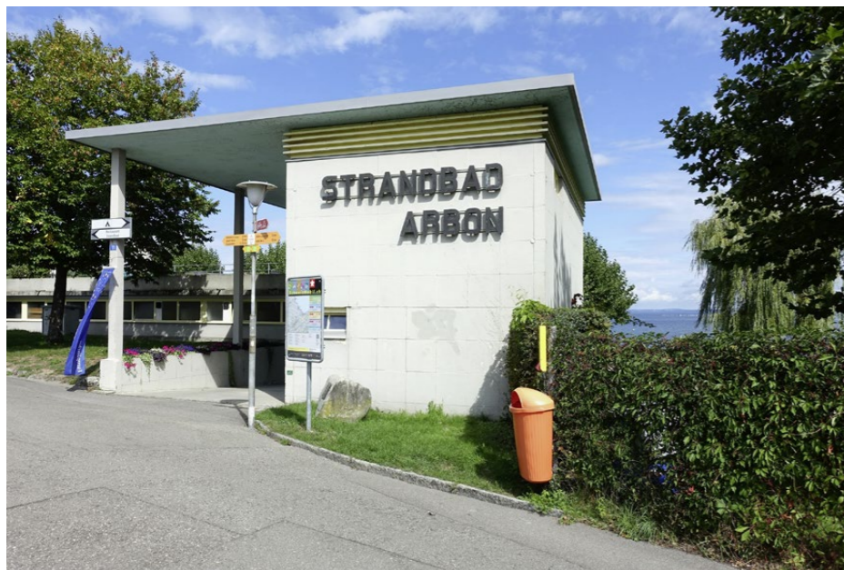
Beim Bahnübergang signalisiert ein kleiner Turm mit Vordach den Eingang ins Strandbad von Arbon. Die «Gebrauchsarchitektur» aus dem Jahr 1933 ist im Originalzustand.
