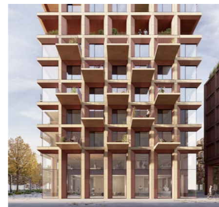
Die Fassade von «Rocket» wird durch das regelmässige, mit Terracotta verkleidete Raster der Tragstruktur gegliedert.
