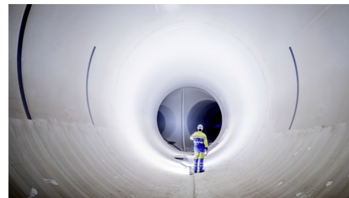
Mai 2018: Gepanzerte Verteilleitung, Durchmesser von 5,5 bis 3,2 Metern.
