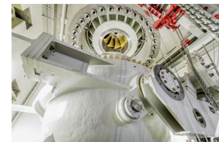
November 2018: Unterhalb der Turbine wird ein Kugelschieber montiert.
