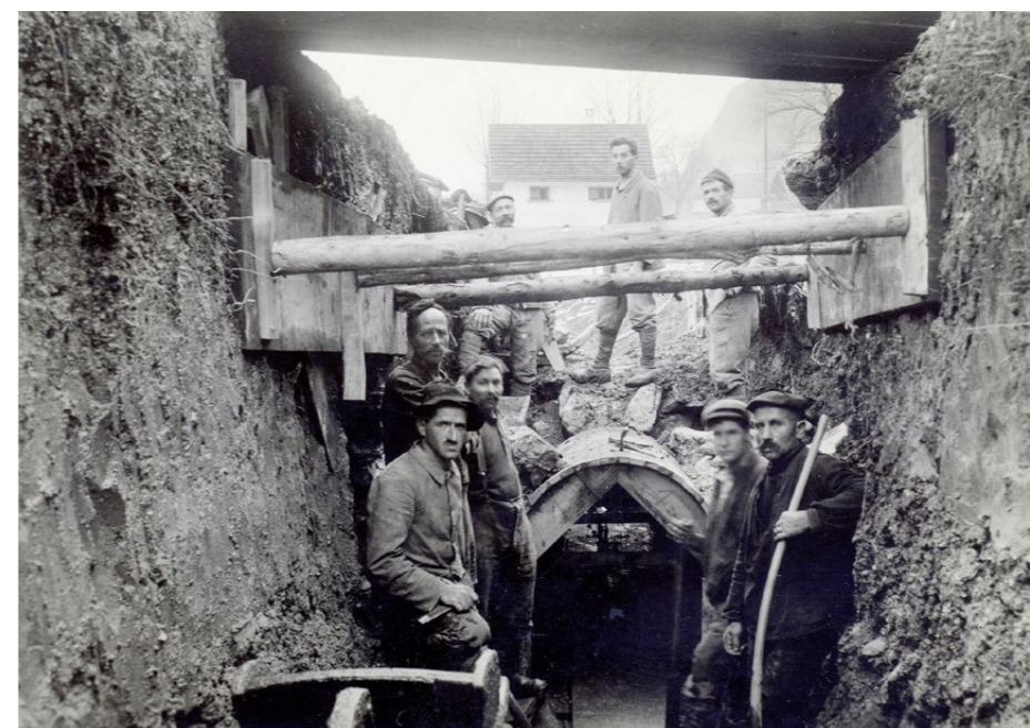
Aus bescheidenen Anfängen entsteht ein schweizweit führendes Spezialunternehmen für Bauarbeiten im und am Fels: Gründer Karl Gasser-Meier (vorne links) 1926 auf der Baustelle Lopp-Kanal Lungern.
