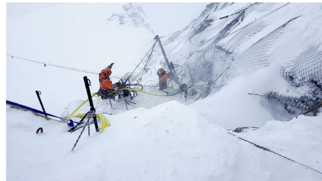
Ein Beispiel für die hohe Spezialisierung sind hochalpine Bohrarbeiten. Im Bild: Bau der 3S-Bahn am Klein Matterhorn im Jahr 2017.
