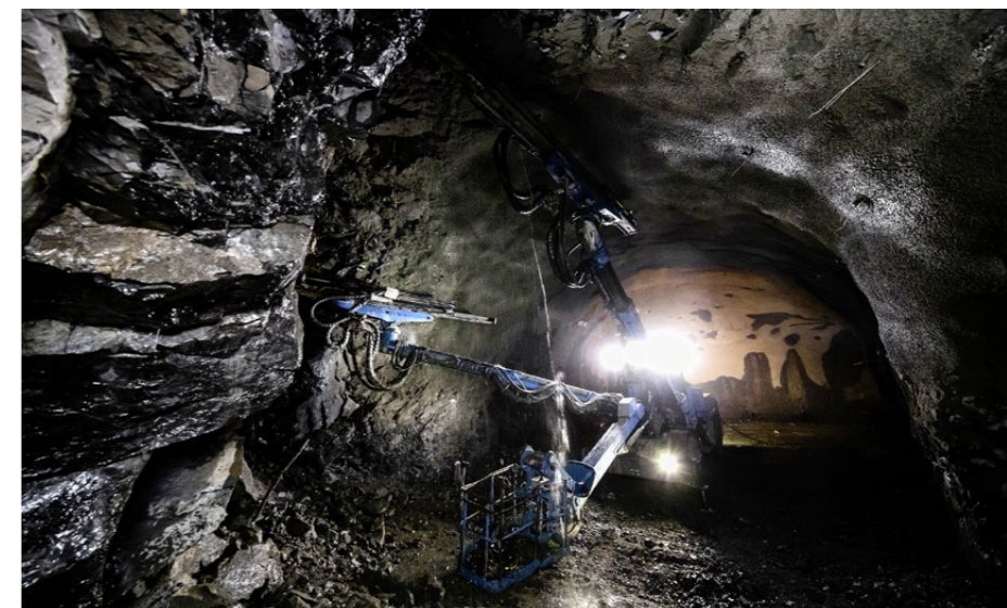
Ein wichtiges Geschäftsfeld ist der Untertagebau. Im Bild: Sprengvortrieb für die unterirdische Erschliessung des Steinbruchs Kehrsiten 2018.
