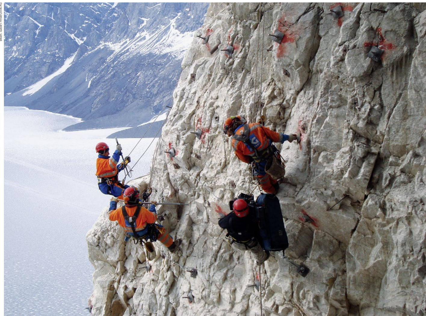
Arbeiten unter Extrembedingungen: Bei Felsicherungsarbeiten bei einem Minenprojekt in Grönland hielt ein BBC-Team im Jahre 2010 die oft unwirklichen Bedingungen für die Felstechniker in einer Dokumentation fest.
