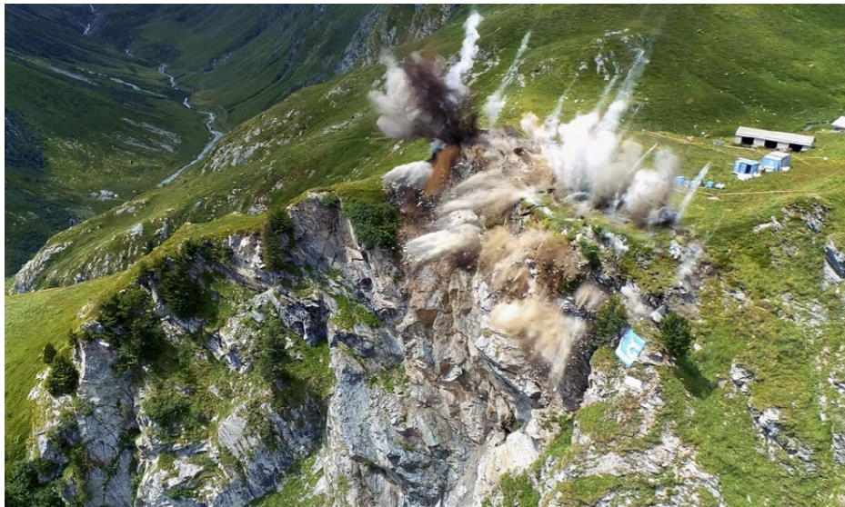
12.000 Kubikmeter Fels wurden 2020 in der Sicherheitssprengung Boca Neira gesprengt.
