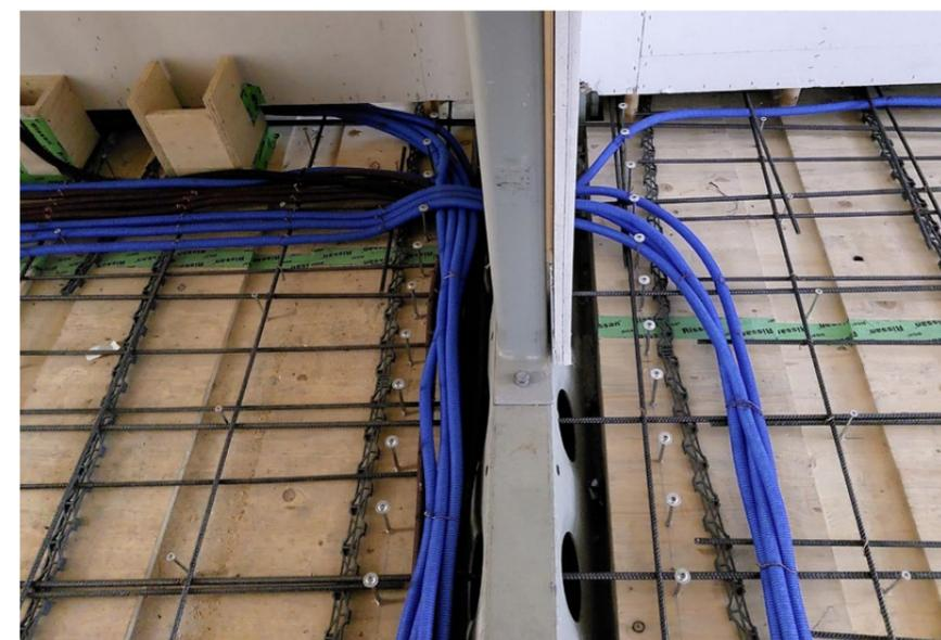
Die Deltabeam Verbundträger sind in die Deckenkonstruktion integriert. Das erleichtert die Installation von Leitungen der technischen Gebäudeausrüstung erheblich.
