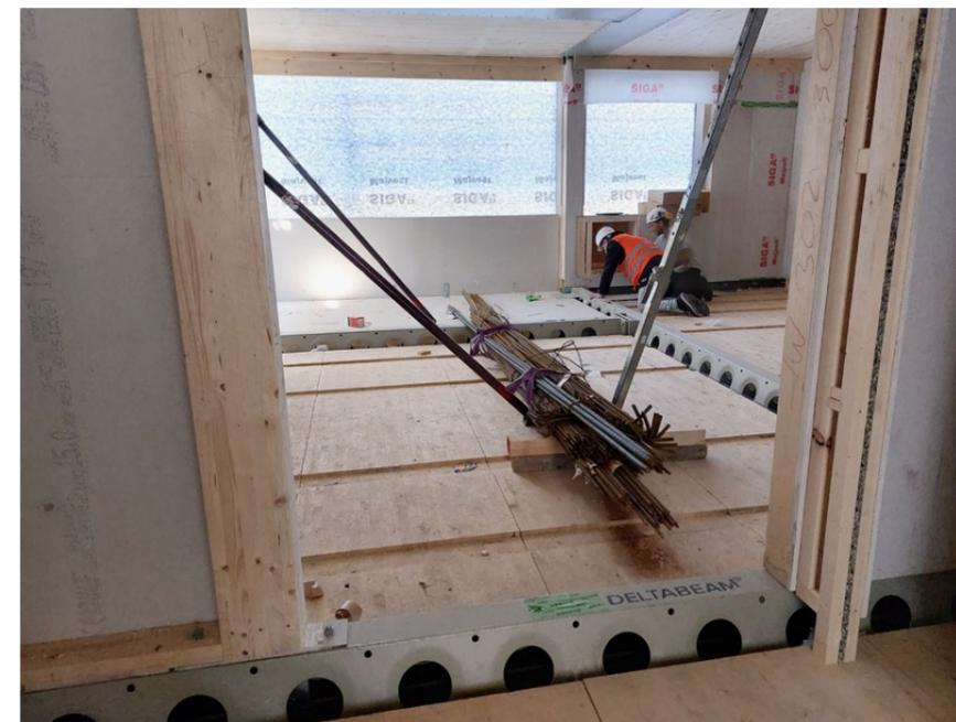
Während des Verlegens der Deckenelemente und beim Verguss der Elemente wirken die Deltabeam als reine Stahlträger, nach dem Ausbetonieren als Stahlverbundträger.
