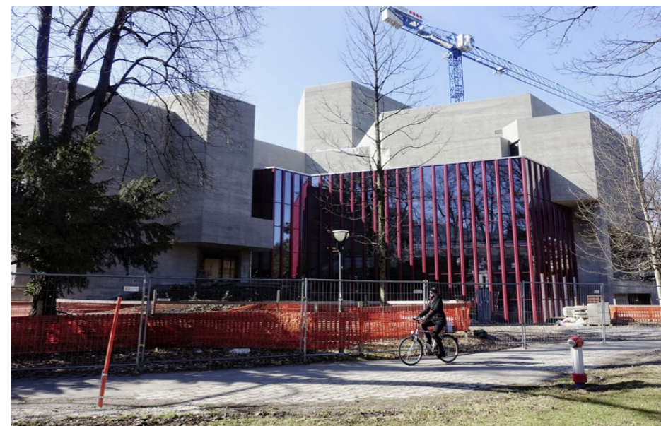
Die grosse Fensterfront Richtung Stadtpark ist äusserst charakteristisch für das Gebäude, weshalb nicht erkennbar ist, dass bei den Fenstern nachgerüstet wurde.
