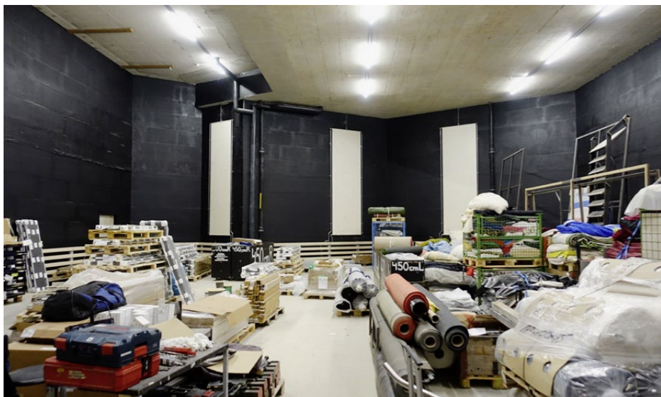
Im letzten Winter wurde die Decke des Bühnenbildlagers erhöht. Dafür musste erst die gesamte Decke abgesägt (Bild oben), die Wände aufbetoniert und eine neue Decke erstellt werden (Bild Mitte). Heute ist davon nichts mehr zu merken (Bild unten).
