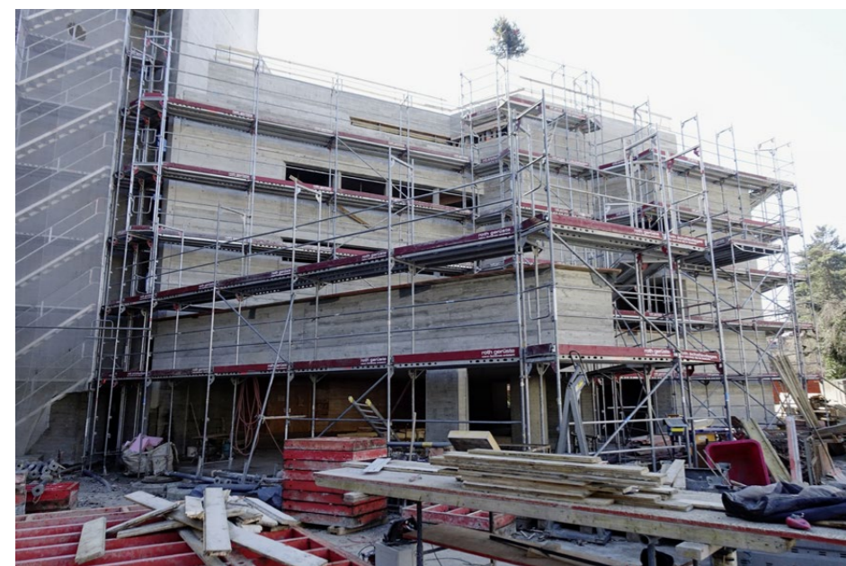
Noch stehen die Gerüste, in Zukunft wird aber kaum ein Unterschied zwischen Alt- und Neubau ersichtlich sein.
