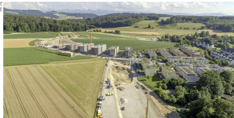
Weil in der Stadt Bern das Angebot an grösseren Wohnungen knapp ist, stehen bei Wegzögern Vorortsgemeinden wie Niederwangen auf dem Gemeindegebiet von Köniz hoch im Kurs. Dort entsteht in Etappen die Überbauung Papillon-Ried.
