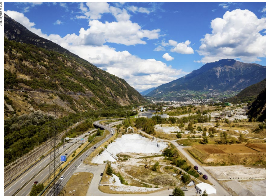
Die Situation in Gamsenried hat auch Einfluss auf die 3. Rhonekorrektur. Auf dem Streckenabschnitt zwischen Brig und Eyholz bei Visp wurden die Bauarbeiten auf später verschoben.
