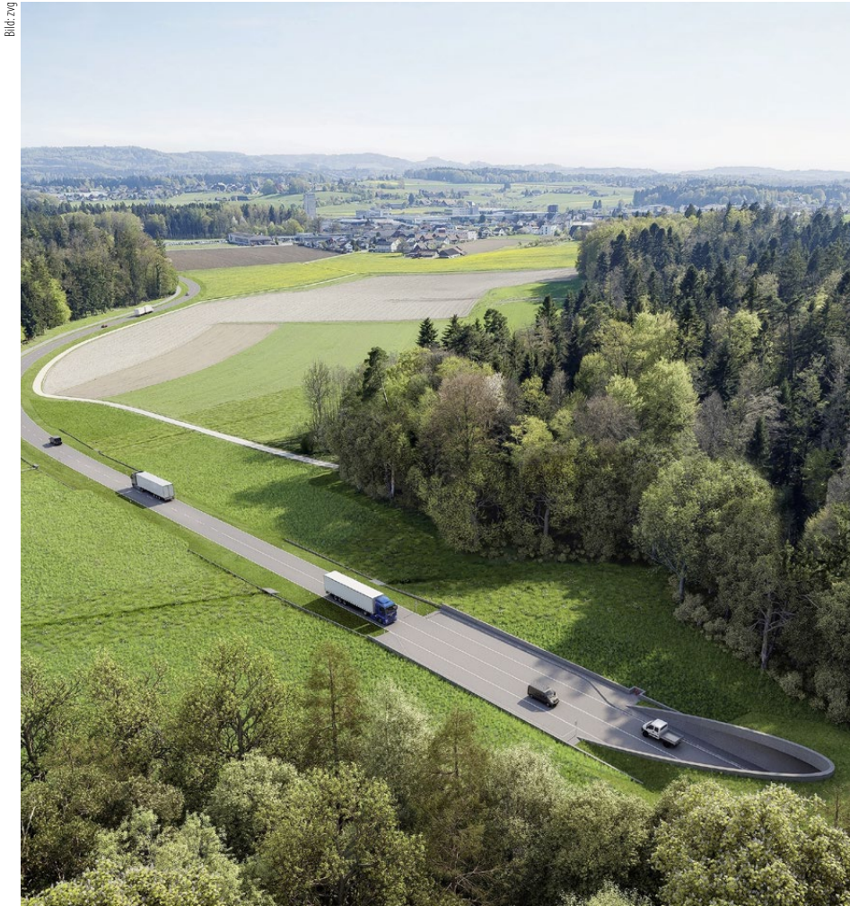
Die Umfahrung Aarwangen umfasst auch den Bau eines Tunnels. Die Kosten belaufen sich auf 194 Millionen Franken. Der Regierungsrat hat den Verpflichtungskredit genehmigt, im Juni entscheidet der Grosse Rat.
