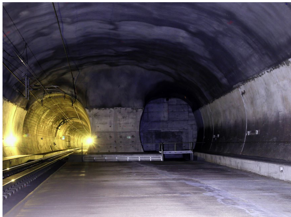
Beim Lötschberg-Basistunnel ist bei Kilometer 22 mit Blickrichtung Süd links die Oströhre zu sehen und rechts die Verbindung zur Rohbau-Röhre, die bei einem Teilausbau neu ausgebrochen werden müsste. Evaluert wird auch ein Vollausbau.
