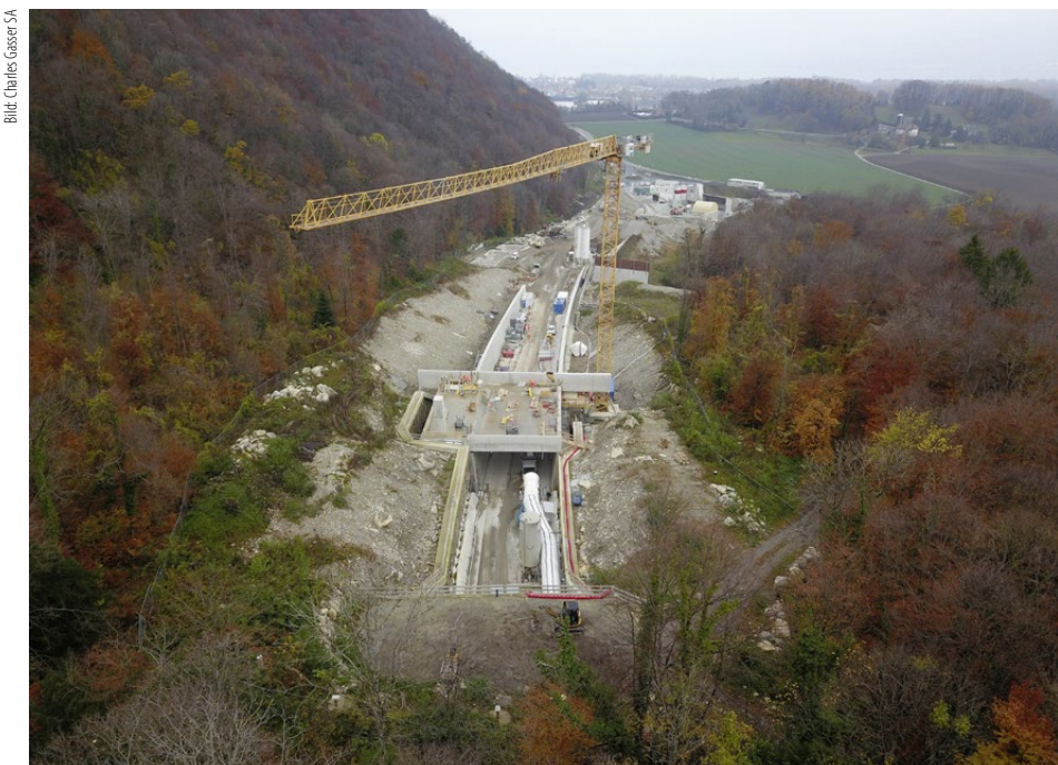
Beim Tunnel Les Evouettes im Unterwallis konnten die unterbrochenen Arbeiten beim Nordportal des Umfahrungstunnels nach einer Bodenabsenkung fortgesetzt werden. Eingebaut wird nun ein Doppelschirmgewölbe.
