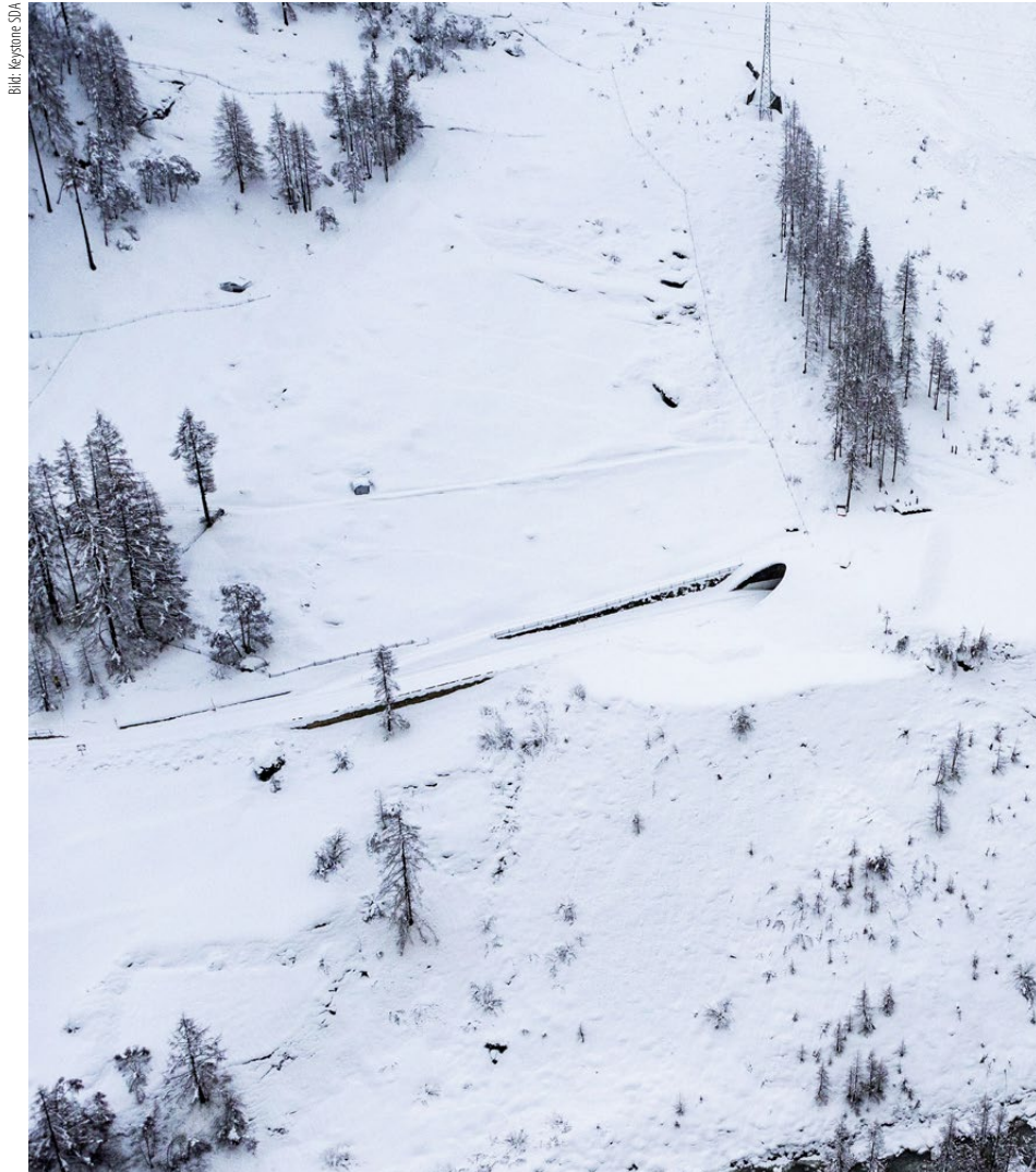
Zwischen Täsch und Zermatt erhöhen zwei geplante Lawinenschutzgalerien die Sicherheit der Strassenverbindung. Das Kantonsparlament hat dazu einen Kredit von 27,3 Millionen Franken genehmigt.
