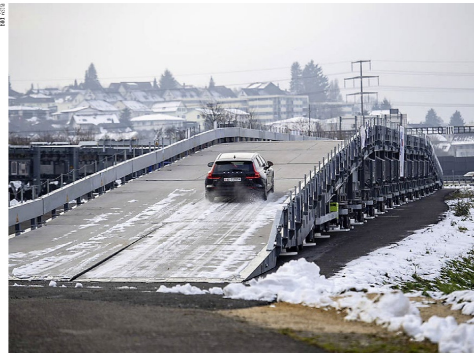
Die Brücke im Test vor der Feuertaufe: Die Versuchsfahrten verliefen reibungslos; bei der Feuertaufe auf der Autobahn machten die Rampen indes Probleme, vor allem bei schwer beladenen Lastwagen.
