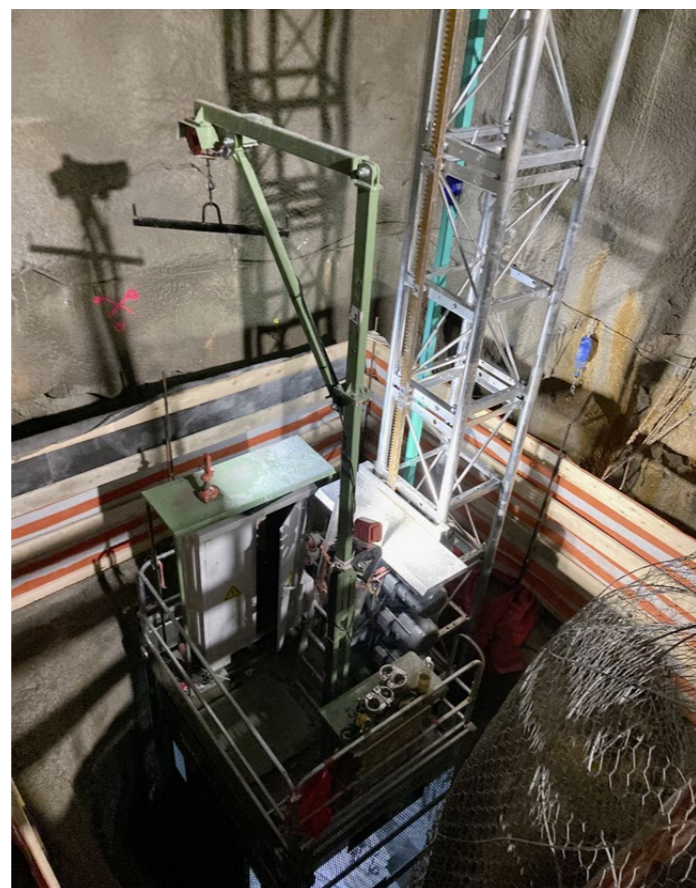
Mit dem auf der Kabine stehenden Kran wurden die Mastelemente montiert.
