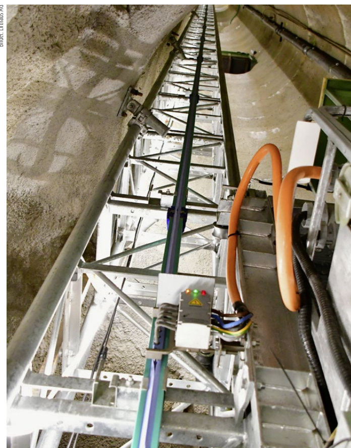
Gut zu erkennen ist das Schienensystem, das für die Stromzufuhr sorgt.
