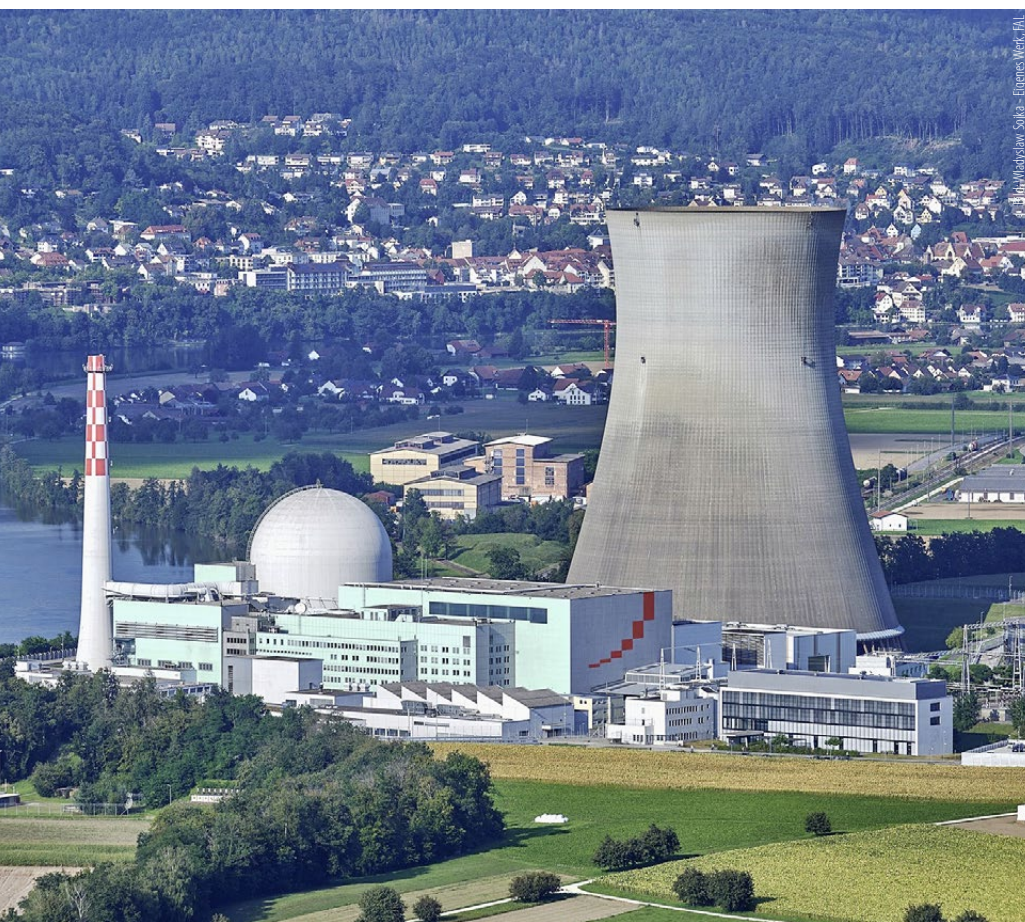
Bei der Planung des Kernkraftwerks Leibstadt legten die Ingenieure eine Laufzeit von vierzig Jahren zugrunde. Alle zehn Jahre erfolgt eine umfangreiche Prüfung.
