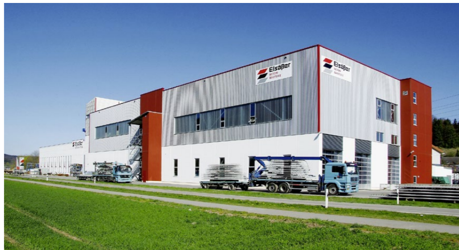
Diese Produktionshalle wurde 2006 in Betrieb genommen und am Standort der allerersten Halle aus dem Jahr 1972 aufgebaut, nachdem diese abgerissen war.
