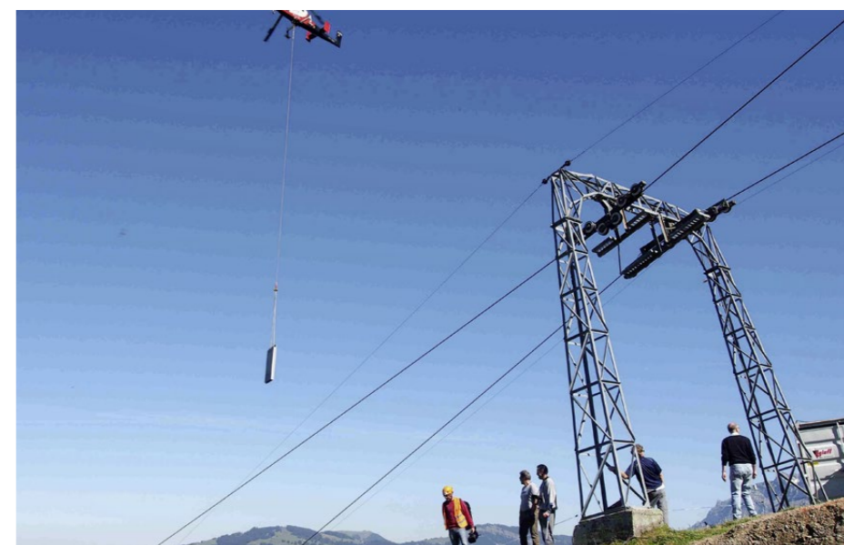
Manchmal wurden sogar per Hubschrauber Betonfertigteilelemente an Schweizer Baustellen geliefert.
