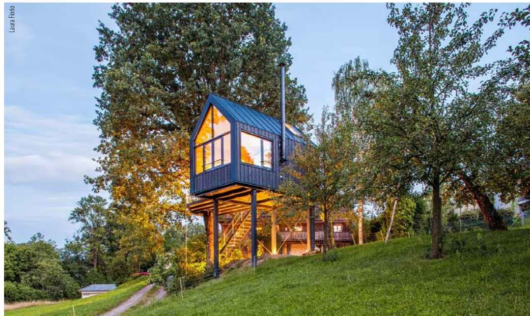
Das Baumhaus «Halden» am Bodensee bietet auf kleinster Fläche allen benötigten Komfort.
