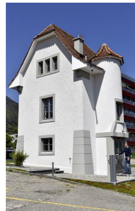
Zaubertürmli: Das Trafogebäude in Grenchen SO wurde von einem pensionierten Unternehmer mit vielen guten Ideen und Liebe zum Detail in ein Wohnhäuschen umgebaut.
