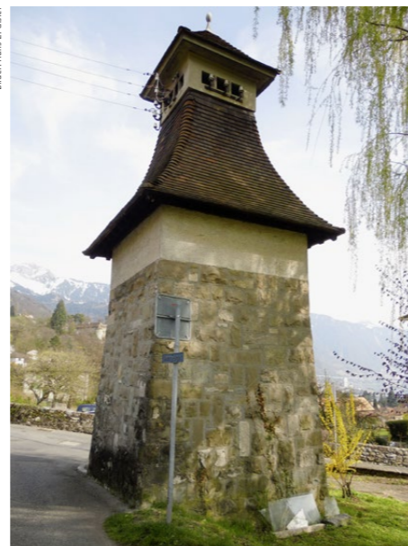
Flaschentrafo aus Stein in Montreux VD: Die modernisierte Transformatorenstation mit einem helmartigen Dach wurde mit einem Rundbogen versehen.
