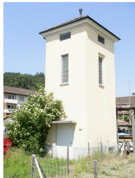
Bei diesem Trafobau in Worb BE fallen die hoch stehenden, gesprossenen Fensterbänder in Kombination mit hochrechten Mauervertiefungen auf.
