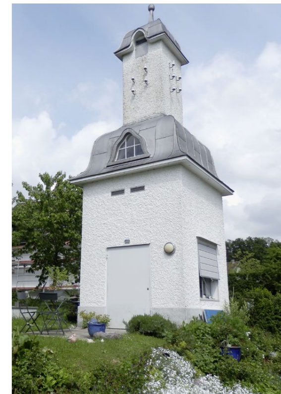
Die Trafostation in Gossau ZH weist ein Helmdach aus Blech mit Lukarnen auf. Darauf erhebt sich ein schlankes Eisenbetontürmchen.
