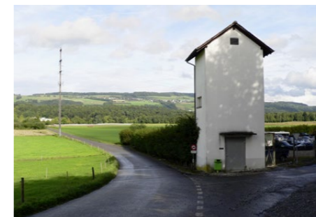
Trafostation in Niederwil AG: Auffällig sind das Satteldach und die querliegenden, gesprossenen Fensterbänder, die asymmetrisch an den Fassaden angeordnet sind.
