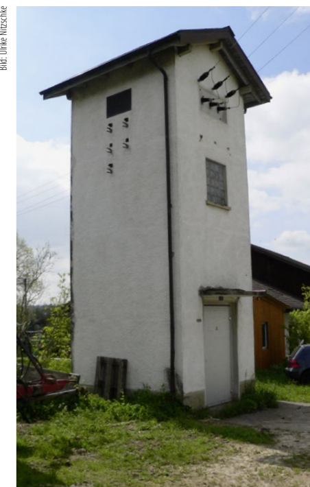
Moderner Trafobau: Die Stromstation in Tramelan BE wurde zweckmässig mit einfachen Fenster- und Türformen sowie mit einem Satteldach gestaltet.
