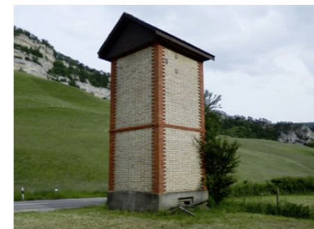
Das Mauerwerk des hoch aufragenden Turmtrafos in Mülliswil SO wurde aus rotem und gelbem Sichtbackstein gebaut.
