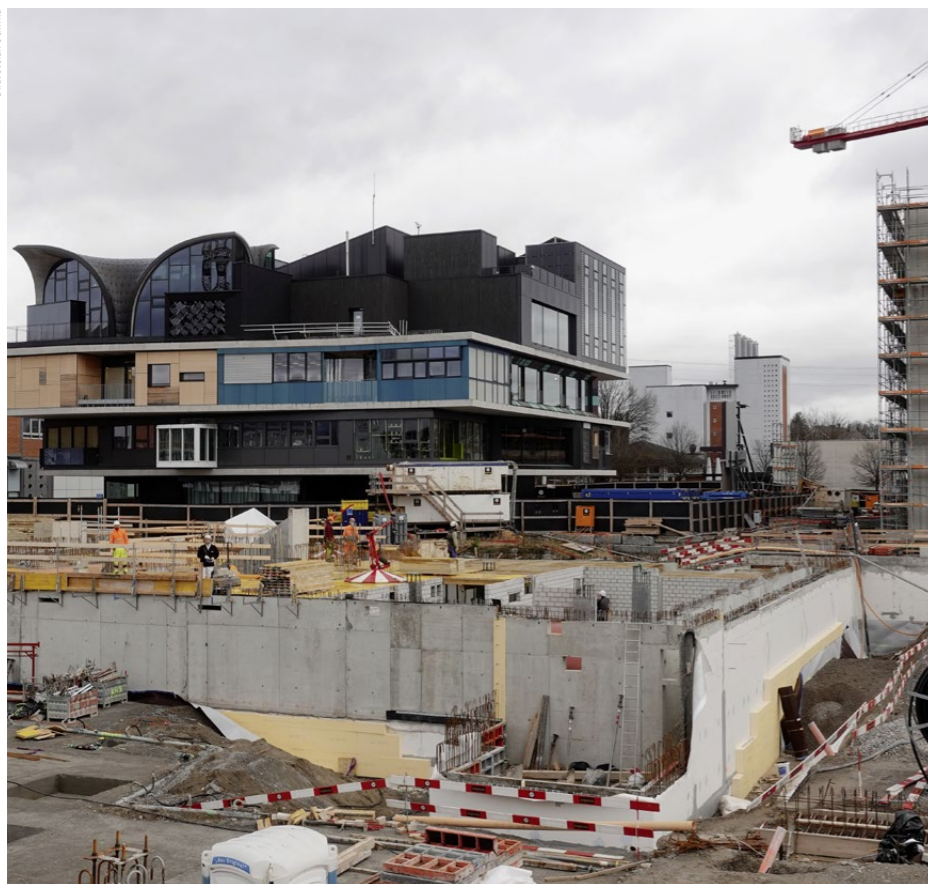
Das Campus-Areal ist sozusagen eine Erweiterung des NEST-Gebäudes (Bildmitte), dessen Nutzung ebenfalls Forschungszwecken dient. Rechts ist das Laborgebäude und hinten die Energiezentrale für das gesamte Empa-Gelände zu sehen.
