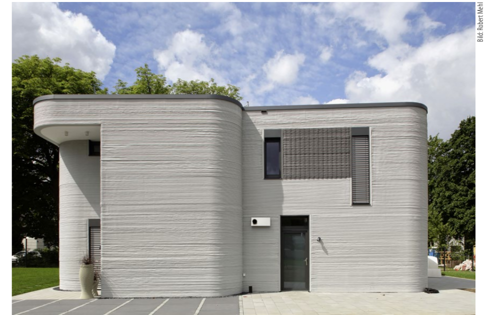
Haus Beckum: das erste, 3D-gedruckte Wohngebäude Deutschlands.
