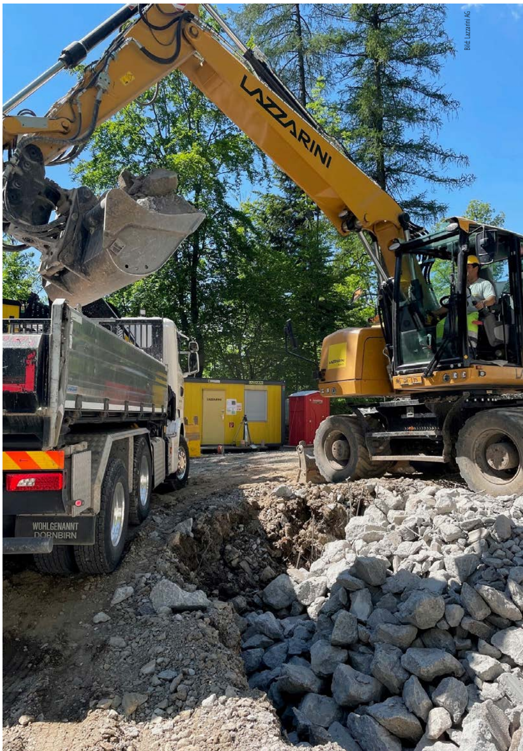
Eine der mit Nutzungsvertrag übernommenen Cat-Neumaschinen der Lazzarini AG im Einsatz.
