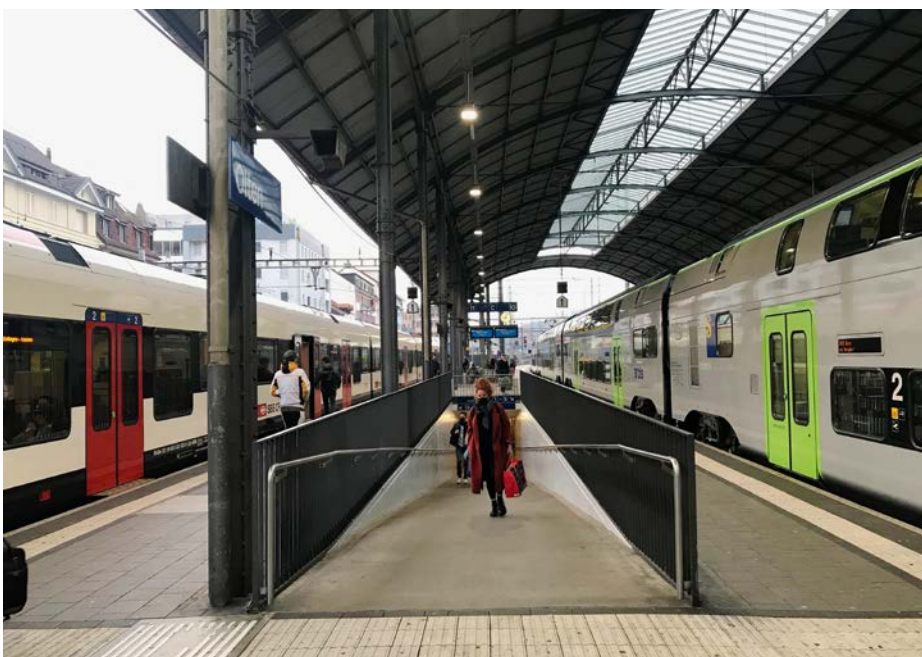
Laut den Vorgaben des BehiG ausgeführter Bahnhof Olten: Die Rampe ermöglicht den freien Zugang mit Rollstuhl, Kinderwagen oder Gepäck, das Leitsystem erleichtert die Orientierung.
