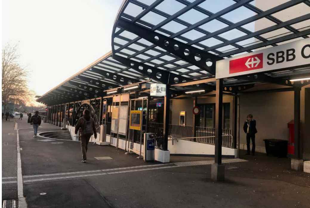
Behindertengerechter Bahnhof Burgdorf: Die taktile Leitlinie führt direkt zur hindernisfreien Rampe. An den Handläufen im Bahnhof sind die Hinweise für den Bahnsteig auch in Braille-Schrift aufgebracht.
