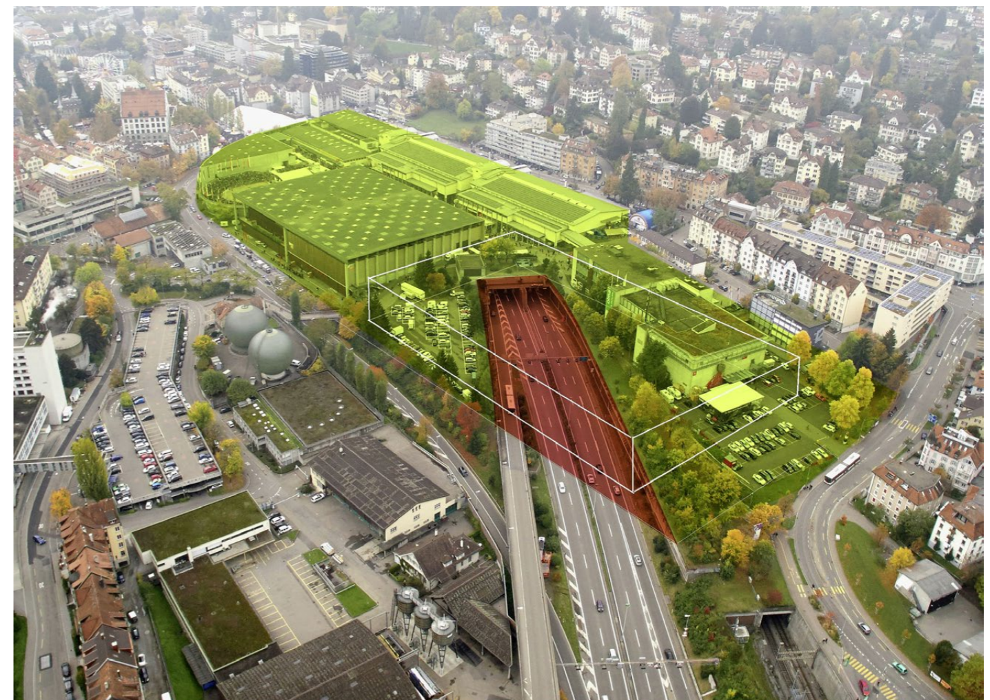
Die neue 12000 Quadratmeter grosse Olmahalle 1 wird bis 2023 auf einem Deckel über der St. Galler Stadtautobahn gebaut.
