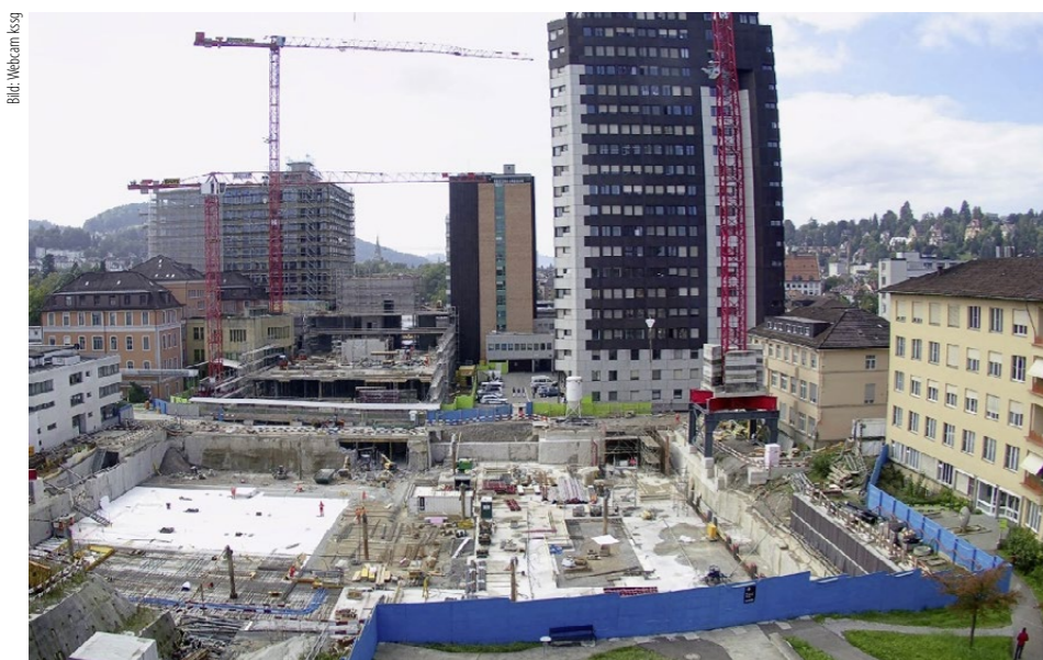
Seit April wird nun auch am neuen Ostschweizer Kinderspital gebaut (Webcam-Bild).
