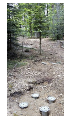
Auf stählernen Füssen steht der Baumwipfelpfad Neckertal. Dank der Schraubfundamente von Krinner gelang eine minimalinvasive Fundamentierung.
