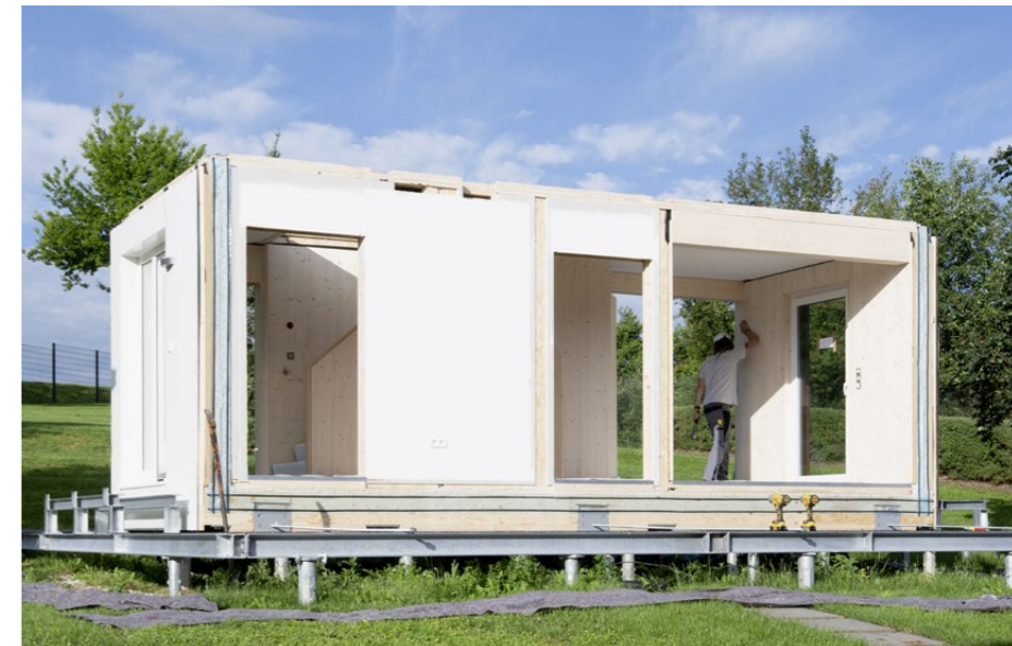
Ohne Keller und Bodenplatte kommt diese Leichtimmobilie aus. Wird sie zurückgebaut, können die Schraubfundamente wiederverwendet werden.
