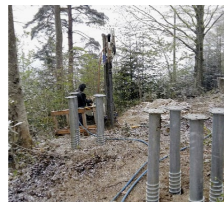
Auf stählernen Füssen steht der Baumwipfelpfad Neckertal. Dank der Schraubfundamente von Krinner gelang eine minimalinvasive Fundamentierung.
