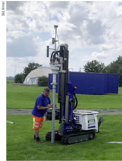
Das Eindrehen von stählernen Fundamenten ist gewissermassen ein minimalinvasiver Vorgang.
