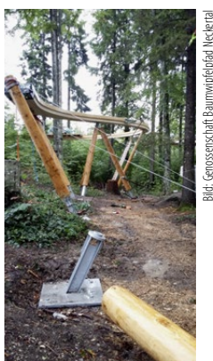
Auf stählernen Füssen steht der Baumwipfelpfad Neckertal. Dank der Schraubfundamente von Krinner gelang eine minimalinvasive Fundamentierung.
