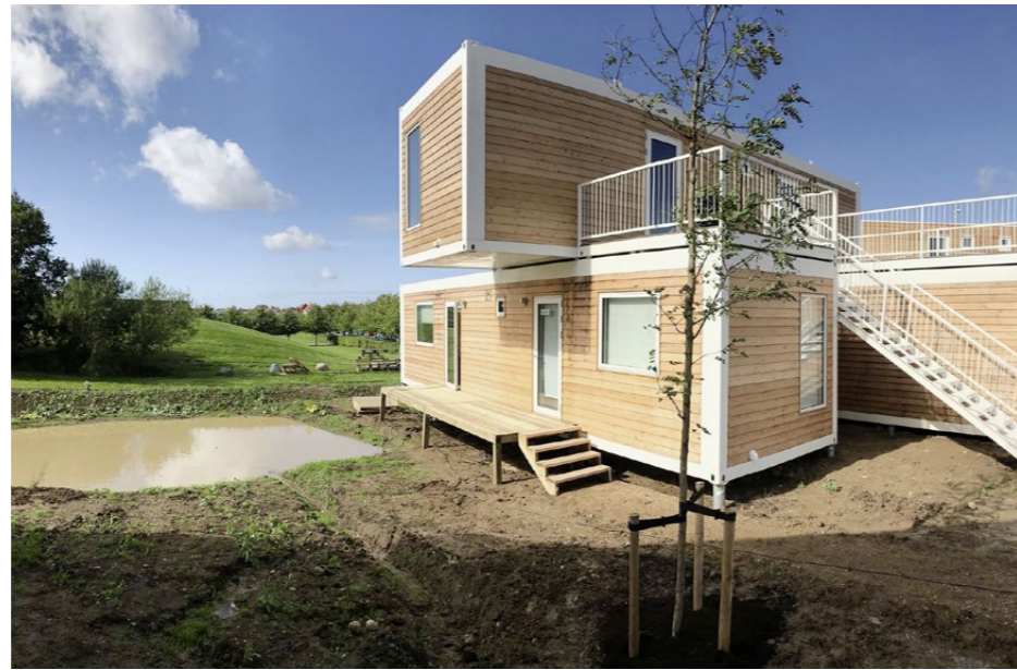
Auch auf weichem und nassem, gering belastbarem Boden lässt sich mit Schraubfundamenten solide planen, bauen und wohnen.
