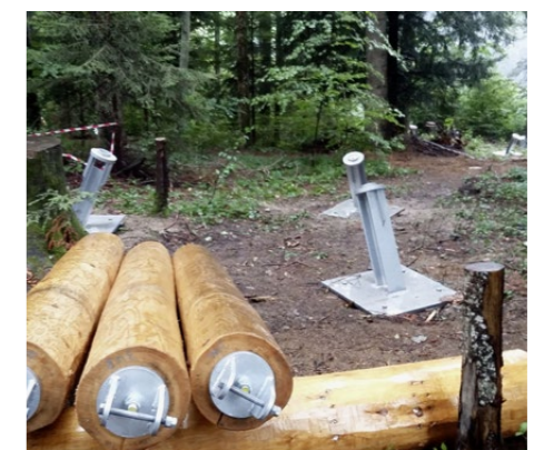
Auf stählernen Füssen steht der Baumwipfelpfad Neckertal. Dank der Schraubfundamente von Krinner gelang eine minimalinvasive Fundamentierung.
