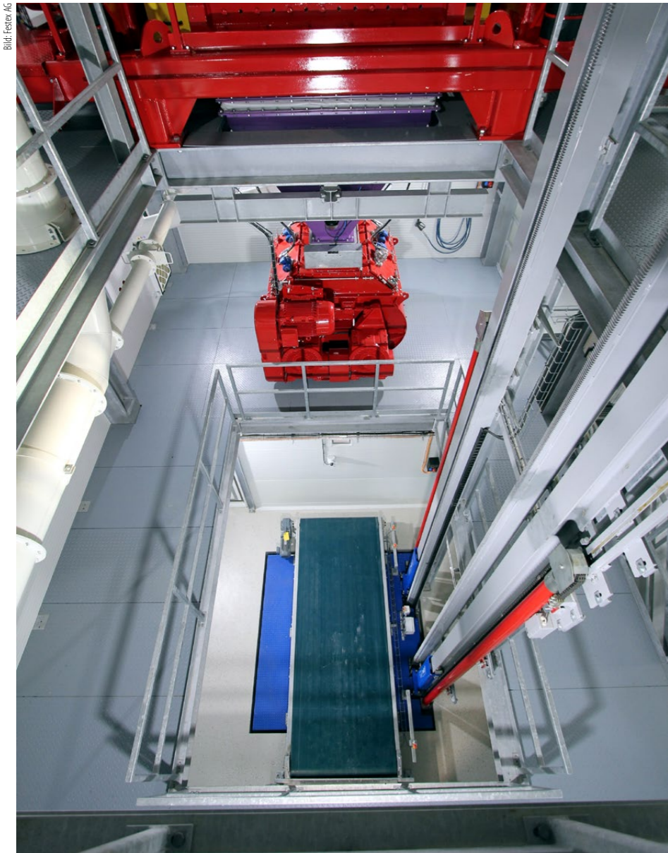
Vom Förderband (unten) werden die Säcke hochgehoben, in den Brecher entleert und dort zerklüffert. Dann wird das Material mit Zement, Wasser und Zuschlagstoffen zu einem Brei vermengt.
