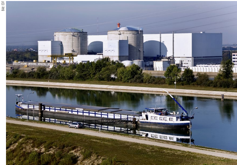
Die Energie wurde von zwei Druckwasserreaktoren mit einer Leistung von je 900 MW produziert.
