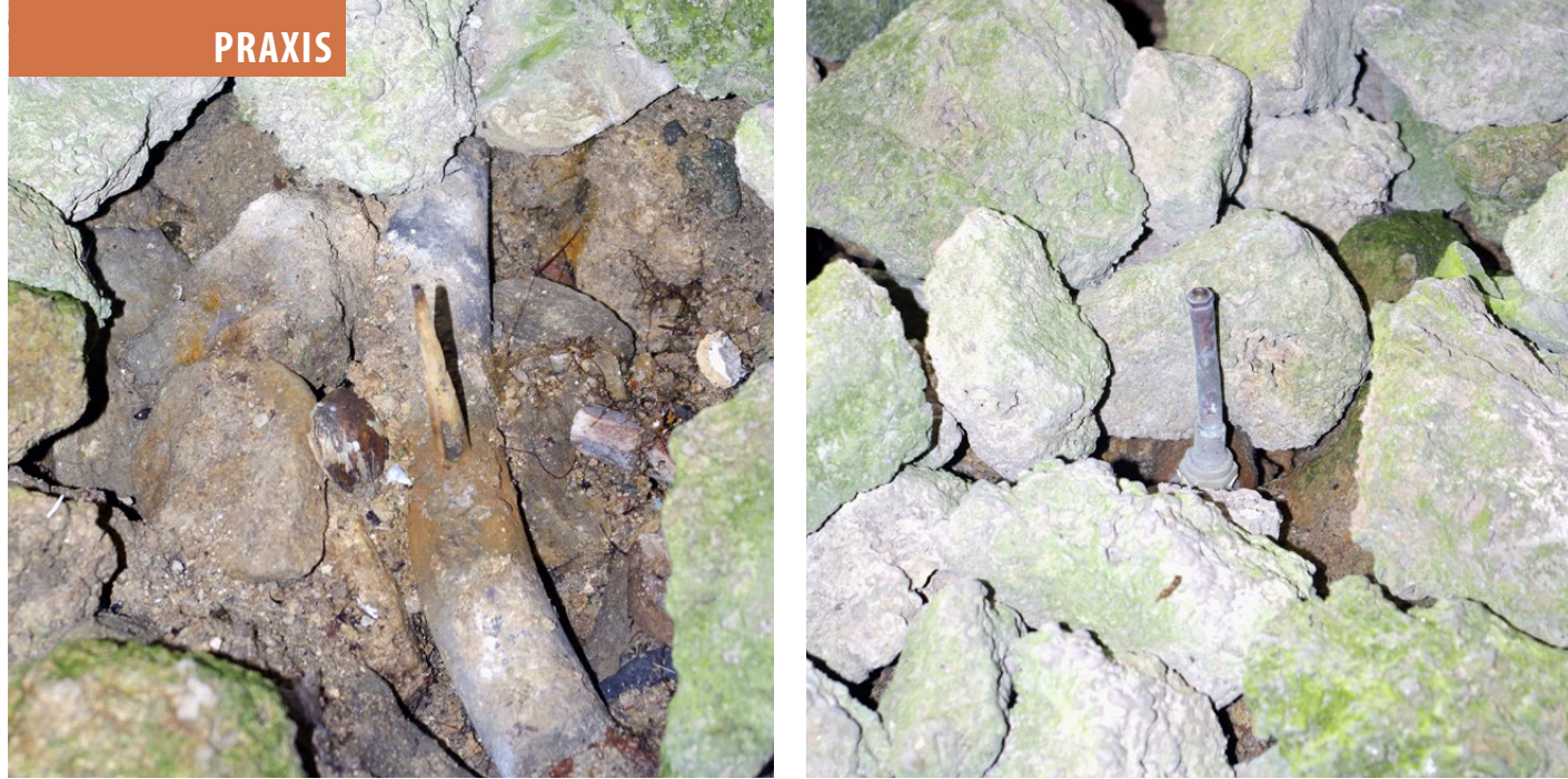
Links ist eine alte Bleidüse zu sehen und rechts eine gewöhnliche Brennerdüse als moderner Ersatz. Zweihundert solche Düsen sind allein im Marmorboden der Schlossgrotte eingelassen.
