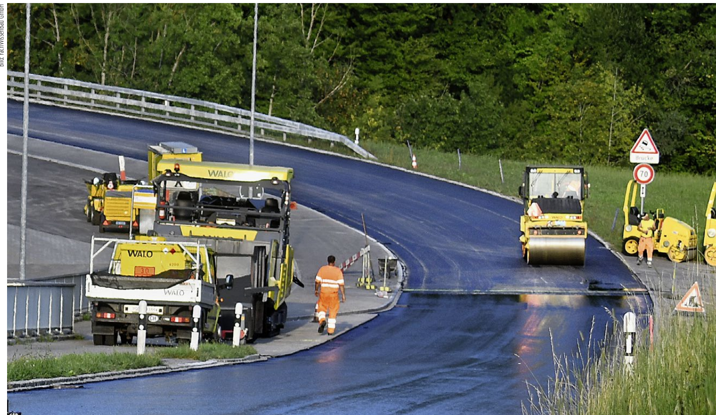
Der Einbau lärmarmen Beläge erfordert ein gutes Zusammenspiel von Belagwerk und Bauunternehmen. Bauherrschaften stellen oft hohe Anforderungen an den Anfangslärmreduktionswert und dessen längerfristige Wirksamkeit.
