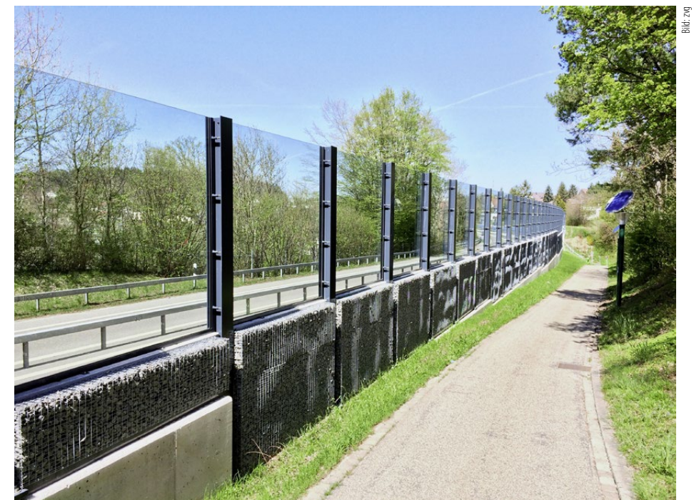
Der Strassenlärm soll mit akustisch wirksamen Belägen direkt an der Quelle reduziert werden. In der Vergangenheit wurden dagegen vor allem Lärmschutzwände installiert.
