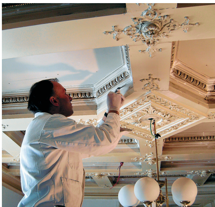
Die Stuckverzierungen wurden von Spezialisten in aufwändiger Arbeit restauriert.
