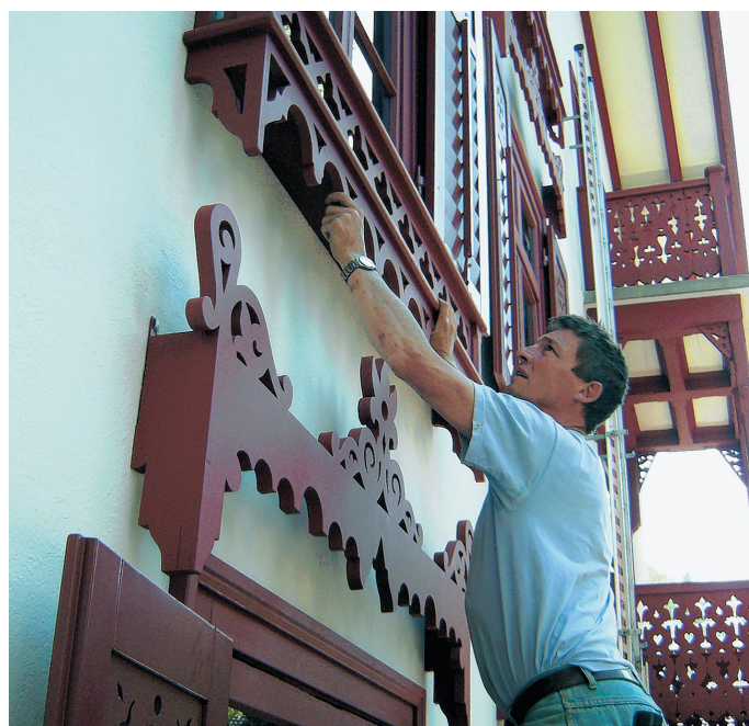
Die filigranen Holzteile für die Nordfassade wurden durch Erich Albisser vom Gletschergarten nachgebaut. (Bilder: zvg)
