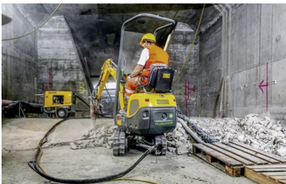
Flexible Einsätze ermöglicht der «803 dual power» von Wacker Neuson: Er wird von einem kompakten, bequem umzusetzenden Elektroaggregat über zwei Schläuche mit Hydrauliköl versorgt und arbeitet dann abgasfrei. Ohne Aggregat ist jederzeit herkömmlicher Dieseltreibetrieb möglich.
