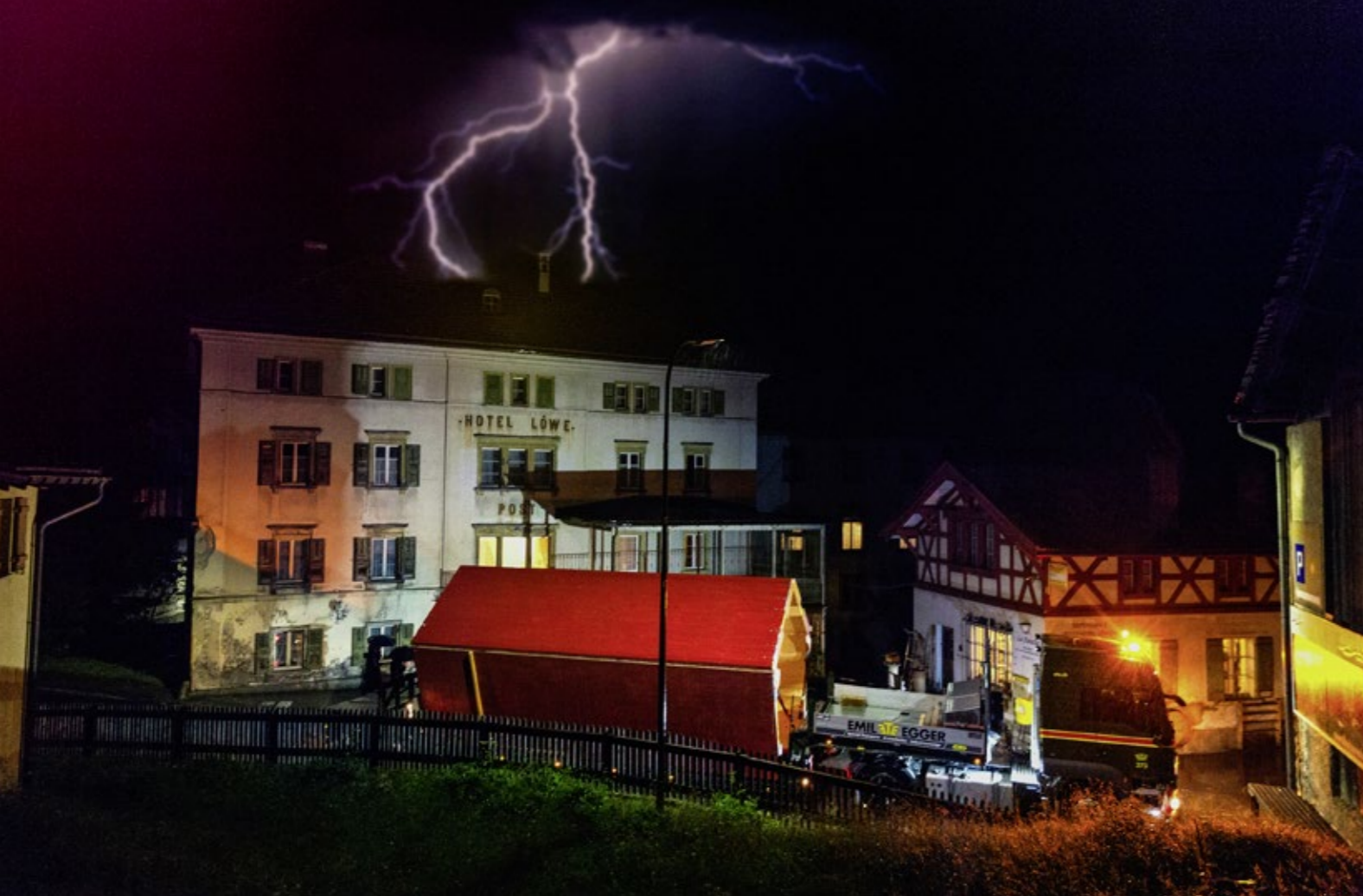
Der Transport der 40 vorgefertigten Turmmodule von Savognin auf den Julierpass verlief spektakulär.
