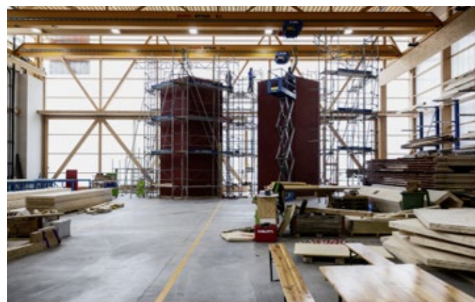
Enrico Uffer räumte eigens seine Abbundhalle in Savognin leer, damit die 40 Turmmodule vorproduziert werden konnte.
