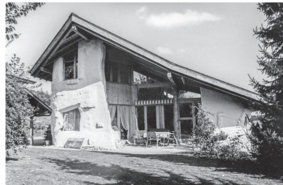
Dieses Haus in Seftigen nennt Stalder liebevoll «Stöckli», da es bereits beim Gesamtprojekt Arzthaus Golder für die Eltern mitgeplant wurde.
