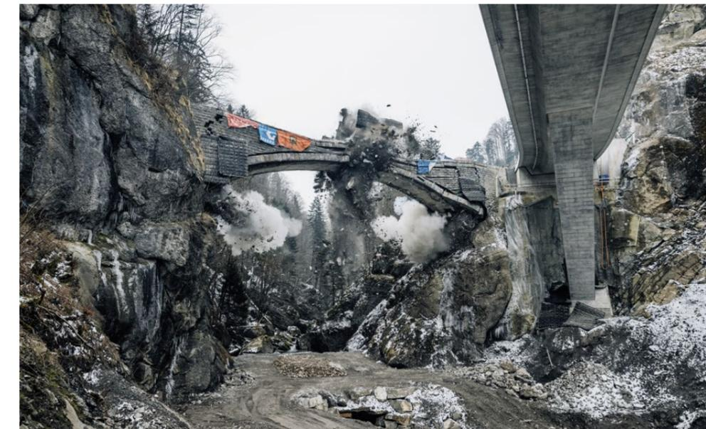
Danach wurden, leicht zeitversetzt, die beiden Seiten mit den Brückenwiderlagern gesprengt.
