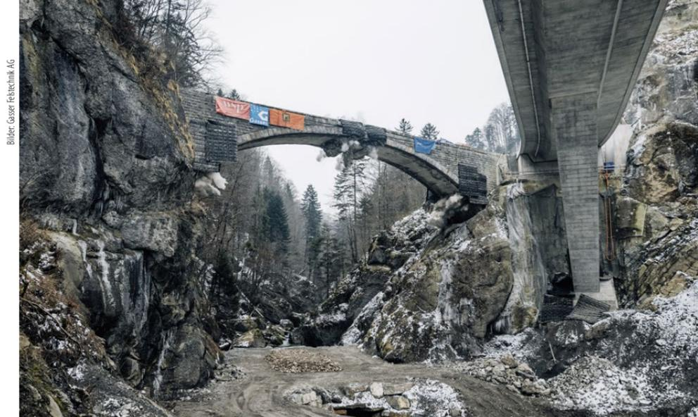
Zuerst liessen die Sprengtechniker die Brückenmitte detonieren.
