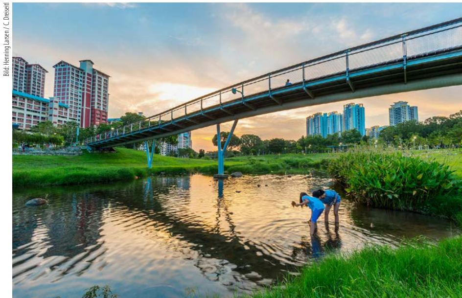
Was einst ein Betonkanal war, ist jetzt eine naturnahe Umgebung.
