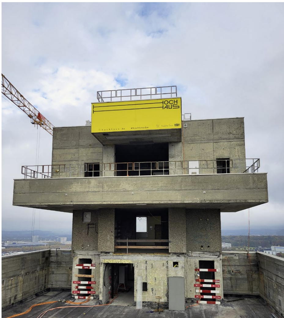
Der Dachaufbau des früheren Bürogebäudes in Ostermündigen: Die Details der Gestaltung dieses Bereiches sind noch in Ausarbeitung.
