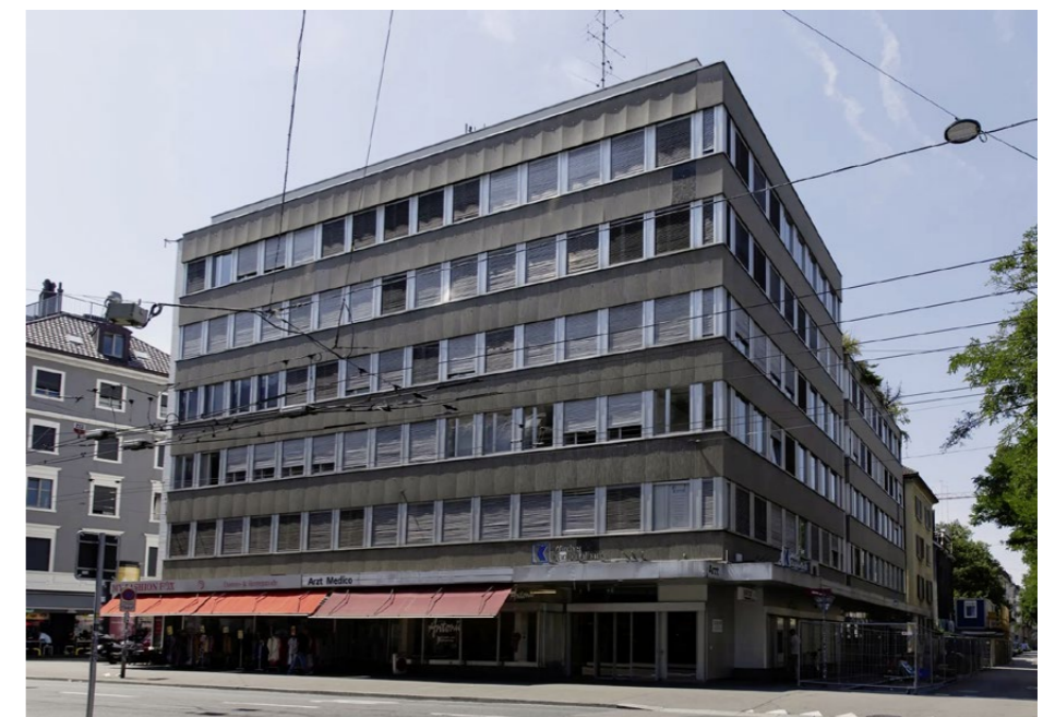
Ein kleineres Umnutzungsprojekt an der Zürcher Langstrasse: In diesem Gebäude sollen 37 Wohneinheiten geschaffen werden.
