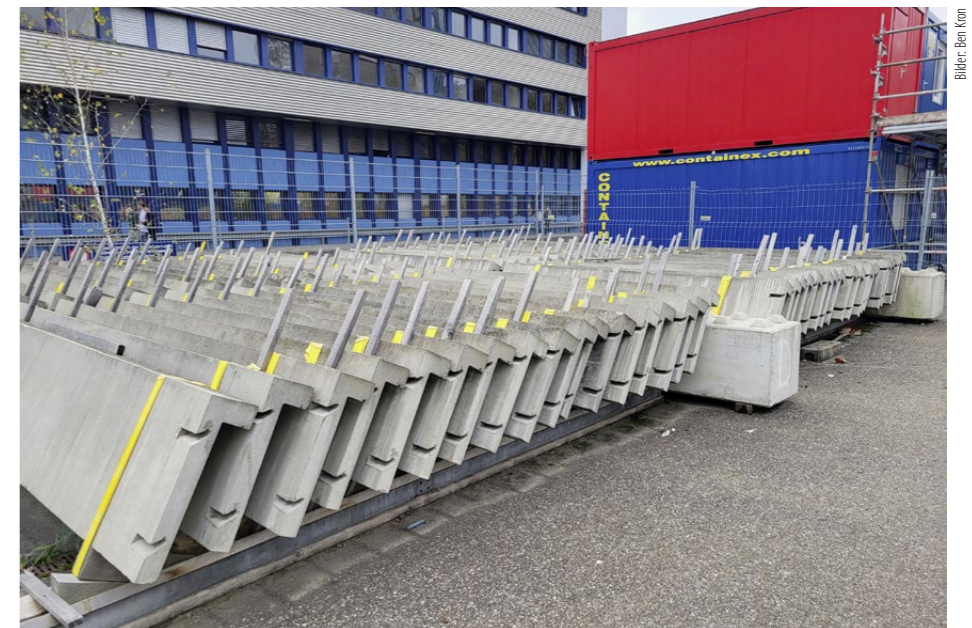
Da die Fassade unter Denkmalschutz steht, werden für die Sanierung entfernte Brise-Soleil-Elemente auf dem Gelände zwischengelagert und am Ende wieder eingebaut.
