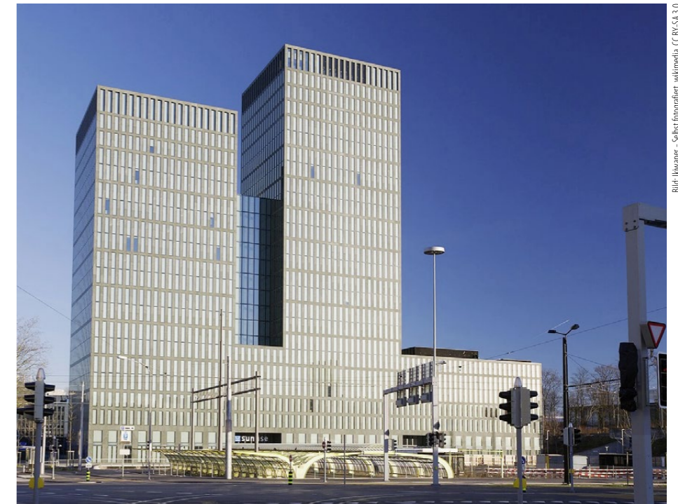
Auch die ehemaligen Sunrise-Tower in Zürich Oerlikon, die seit dem Untergang der CS leer stehen, werden in Wohnungen umfunktioniert.
