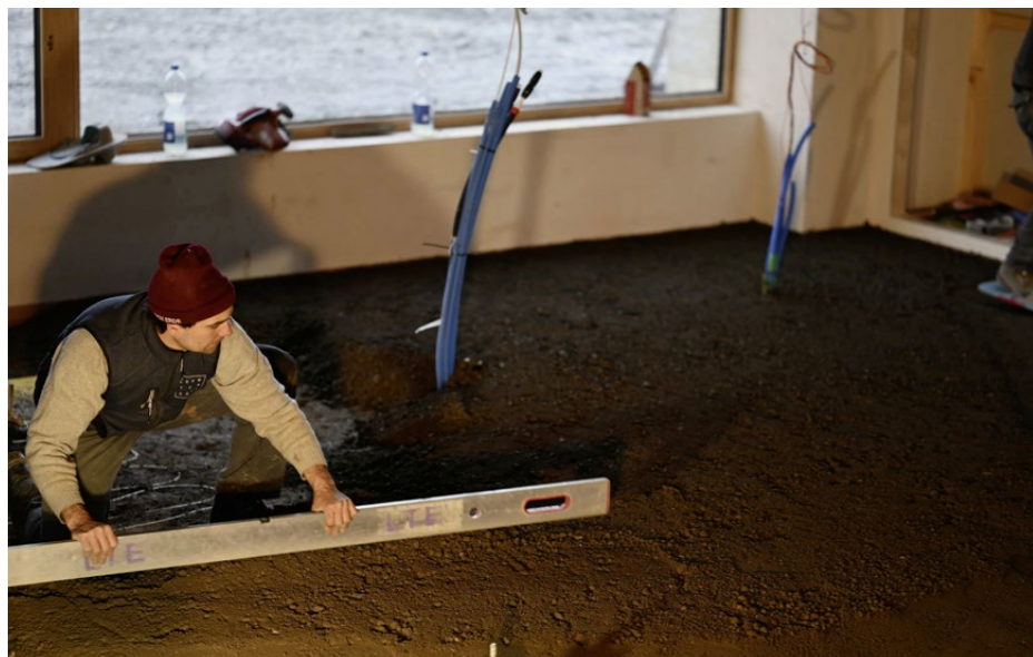
Das Aushubmaterial wird als Bodenschüttung im Neubau verwendet.
