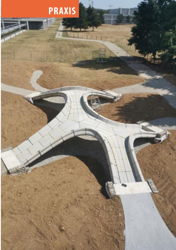
Der Richtfestzustand: Die fertig montierte Betonkonstruktion der Brückenskulptur. Hier aber noch ohne Edelstahlgeländer.
