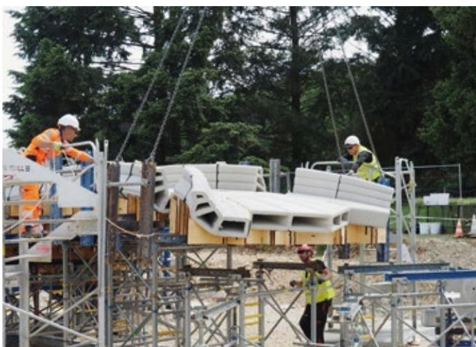
Errichtet wurde die Brückenskulptur durch Auflegen der gedruckten Betonelemente auf ein handelsübliches Lehrgerüst aus Stahl.
