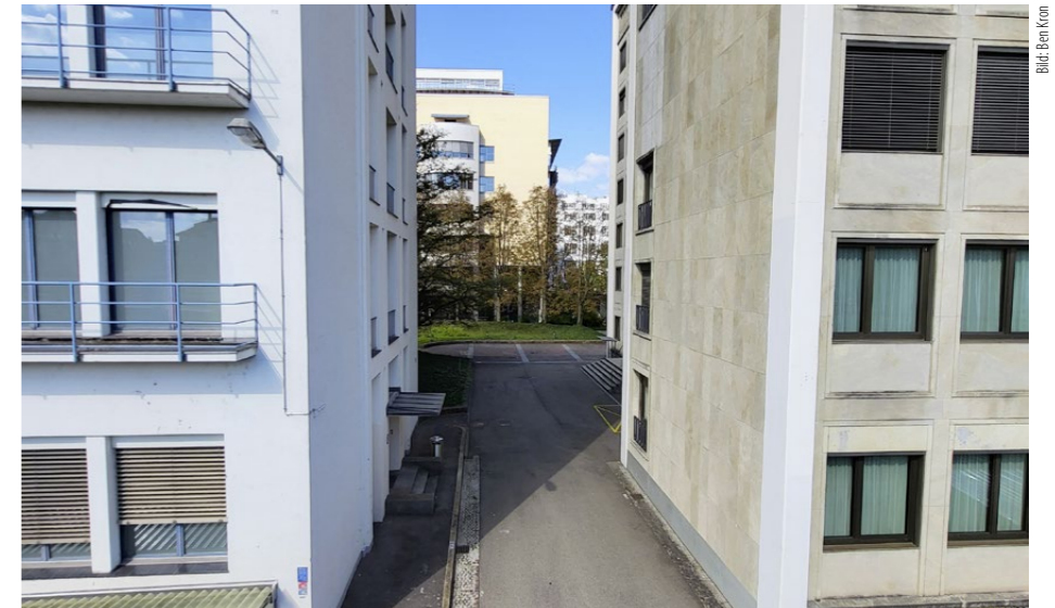
Leerstehende Laborgebäude der Novartis: Mit dem Projekt Rhystadt soll Wohnraum für 10 000 Menschen entstehen.
