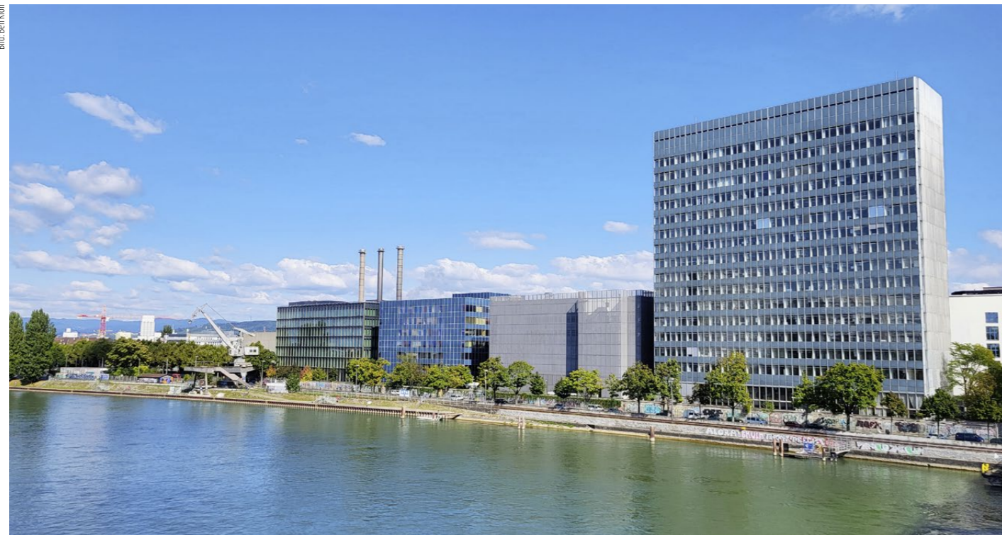
Ungenutzte Büro- und Industriegebäude auf dem früheren Werkareal Klybeck im Kleinbasel: Hier soll die Stadt ein neues Wohnquartier erhalten.
