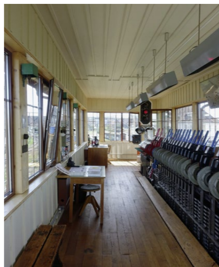
Der «Befehlsraum» ist noch bedienbar. Die Fenster wurden ersetzt, mit einer vorgesetzten ursprünglichen Sprossengliederung.
