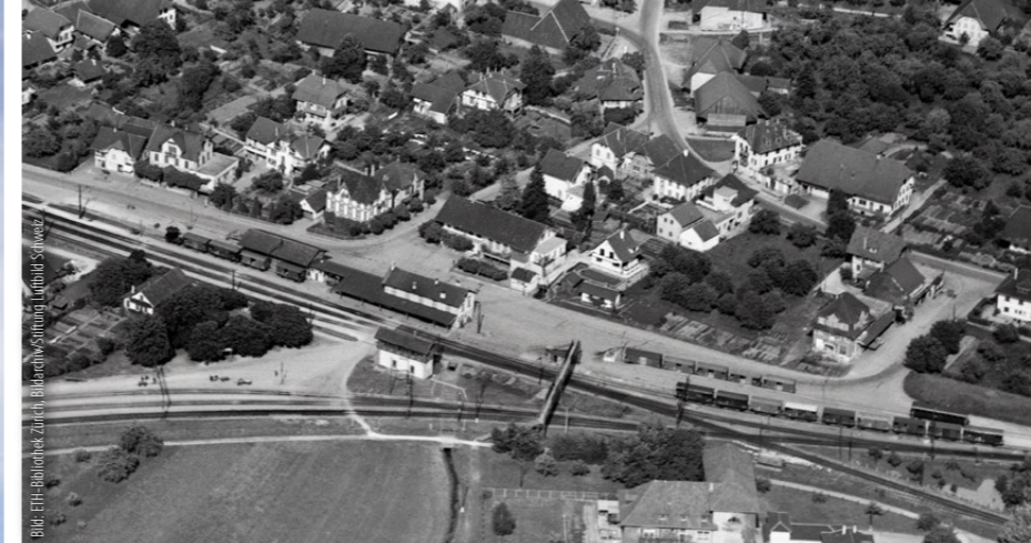
Die Luftaufnahme aus dem Jahr 1949 zeigt den Bahnhof, die Passerelle und die Kreuzung. Die Gleise konnten auch ebenerdig überquert werden.
