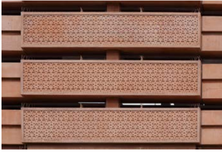
Sternendekor der geschichteten Betonfertigteil-elemente des oberen Pagodenteils.
