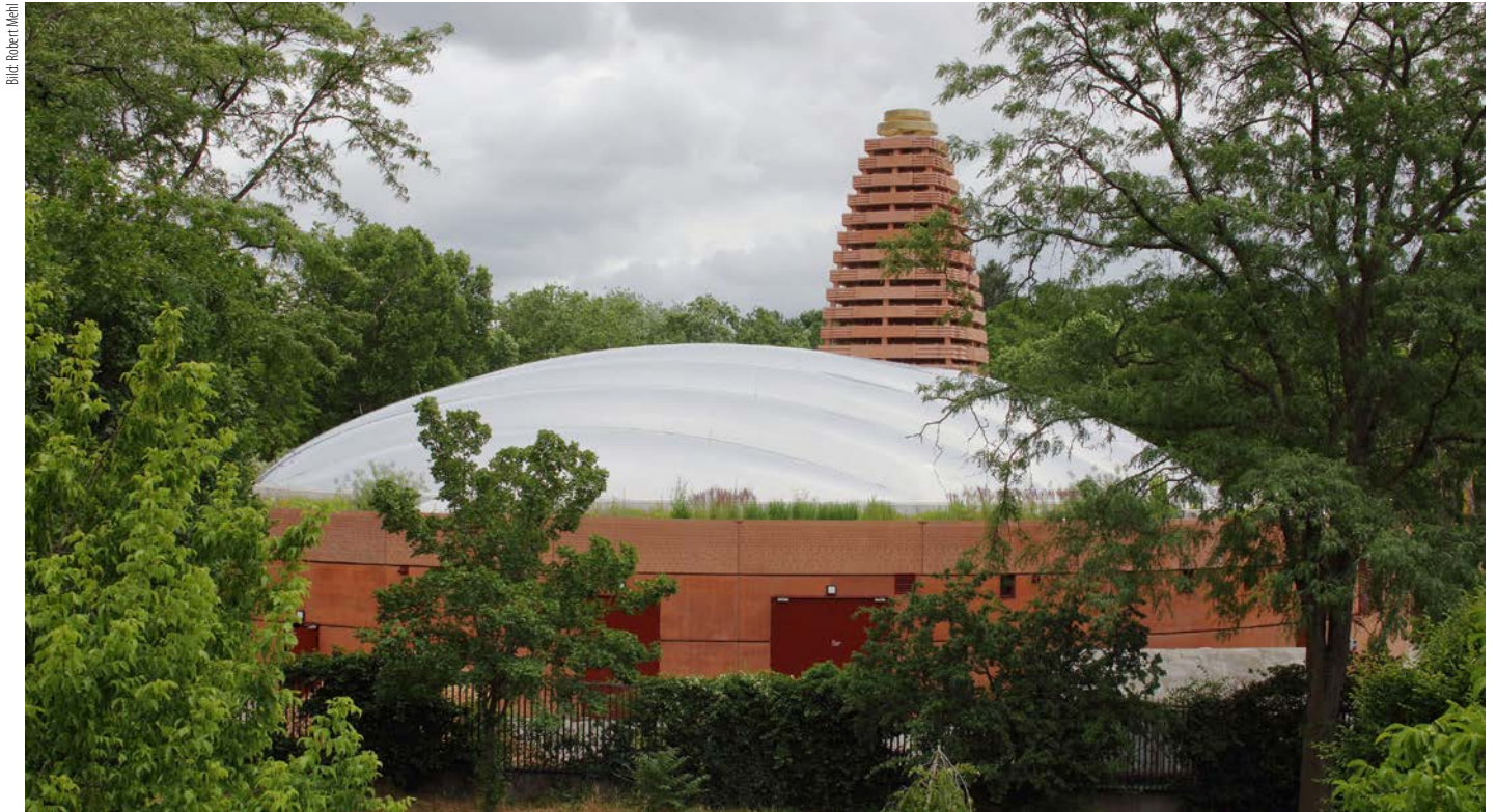
Erhöhte Westansicht der Nashorn Pagode vom Bahnsteig des Bahnhofs zoologischer Garten.
