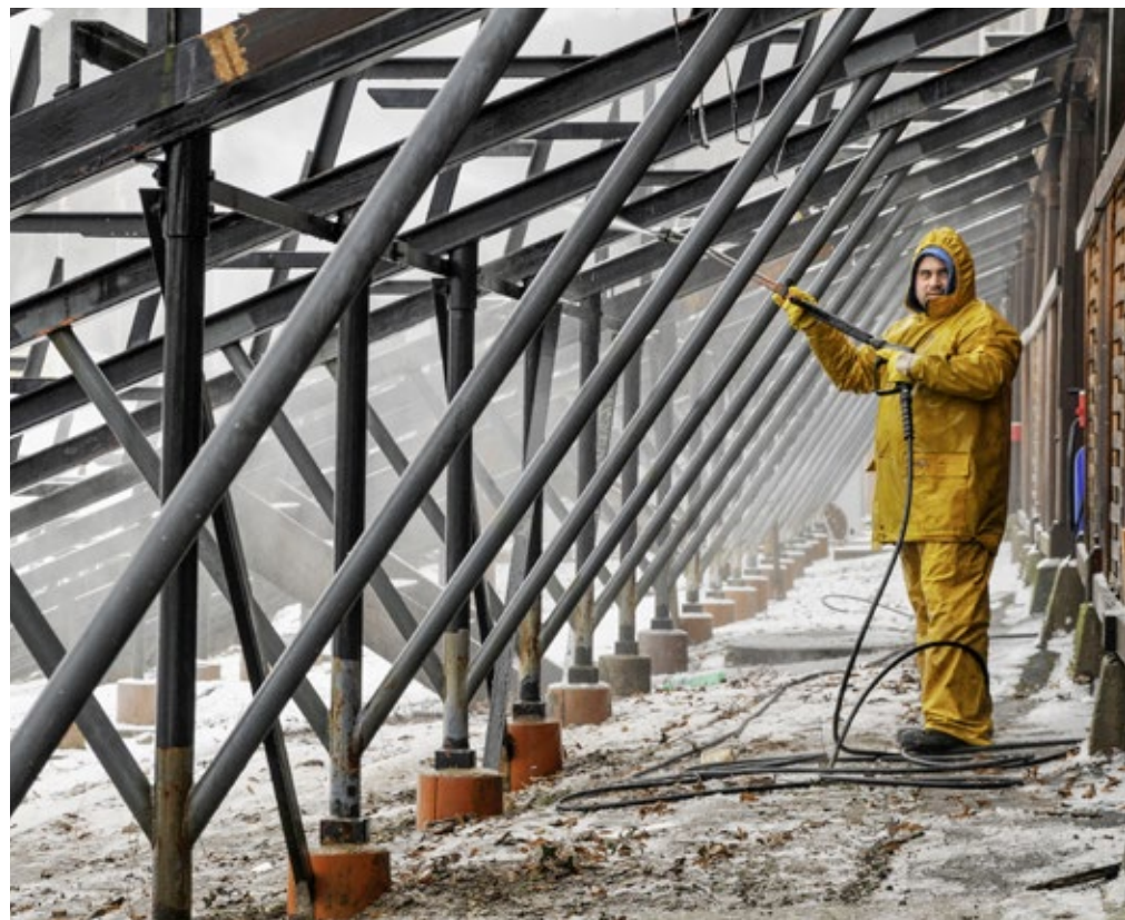
Die Metallträger der Haupttribüne sind in gutem Zustand. Nach der Reinigung mit dem Hochdruckgerät (hier im Bild) werden die Stützen lediglich mit einem Rostschutz versehen. Saniert wird auch die Betonunterkonstruktion der Gegentribüne.
