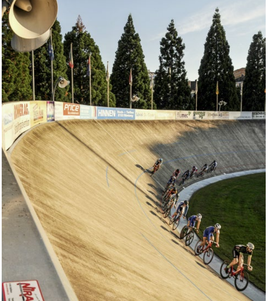
Die Beton-Fahrbahn ist noch heute in renntauglichem Zustand, eine Sanierung ist nicht notwendig. Bereits im Mai finden auf der altherwürdigen Bahn wieder Rennen statt.
