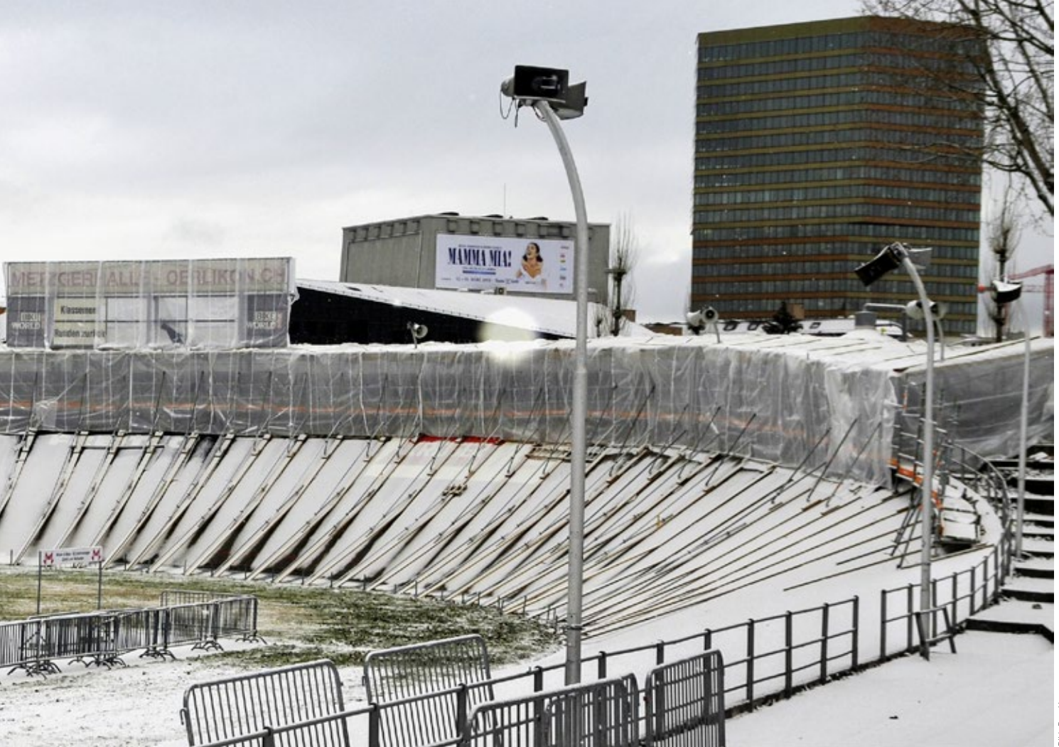
Die Nordkurve ist eingehaust und beheizt, um im Winter die Sanierungsarbeiten ausführen zu können.
