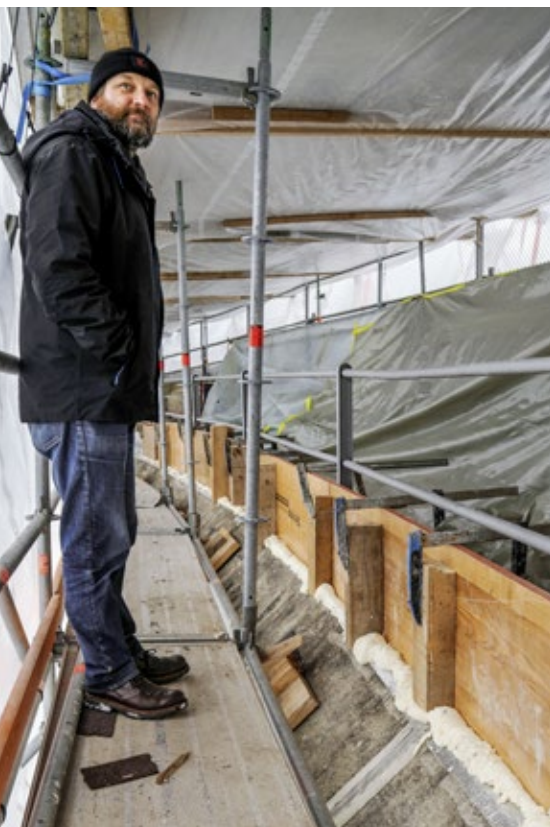
Architekt und Radsportfan Volker Schopp prüft die Einhausung der Nordkurve, deren Geometrie hohe Anforderungen an die Gerüstbauer stellte.
