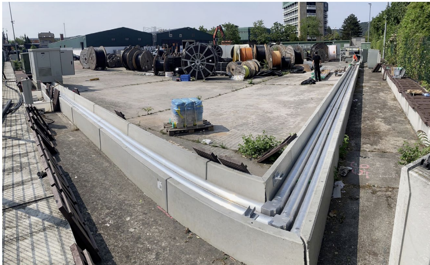
Installationsbeispiel eines Druckluftkabels für 36 Kilovolt bei einer Stromstärke von 3000 Ampere.
