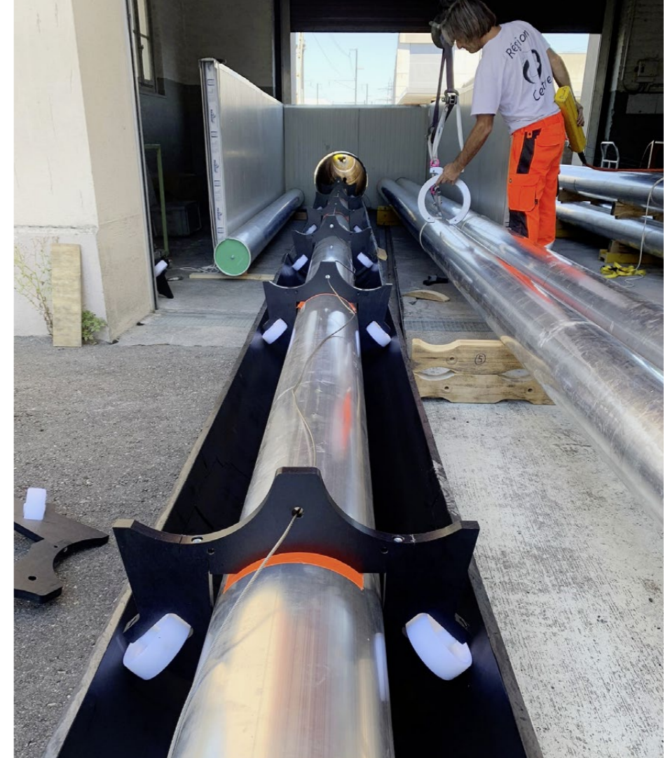
Das Rollensystem und die Vorrichtung zum Einziehen des Kabels haben sich bewährt. In 20 Minuten sind fünf Laufmeter verbunden und installiert.
