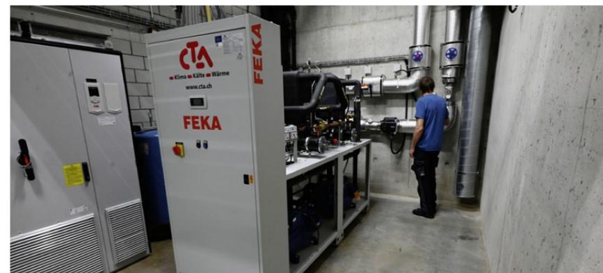
Mittels einer grossen FEKA-Anlage kann bei der Schwimmhalle die Abwärme zurückgewonnen und für die Brauchwassererwärmung genutzt werden.
