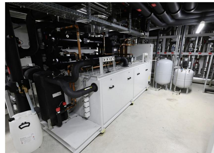
Herzstück der Anlage ist eine grosse Wärmepumpe/Kältemaschine in der Technikzentrale.
